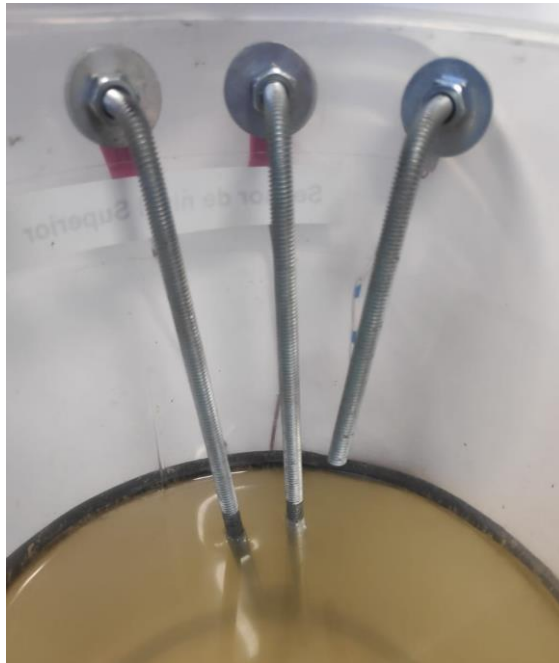
Ilustración 28: Sensor de nivel del tanque
