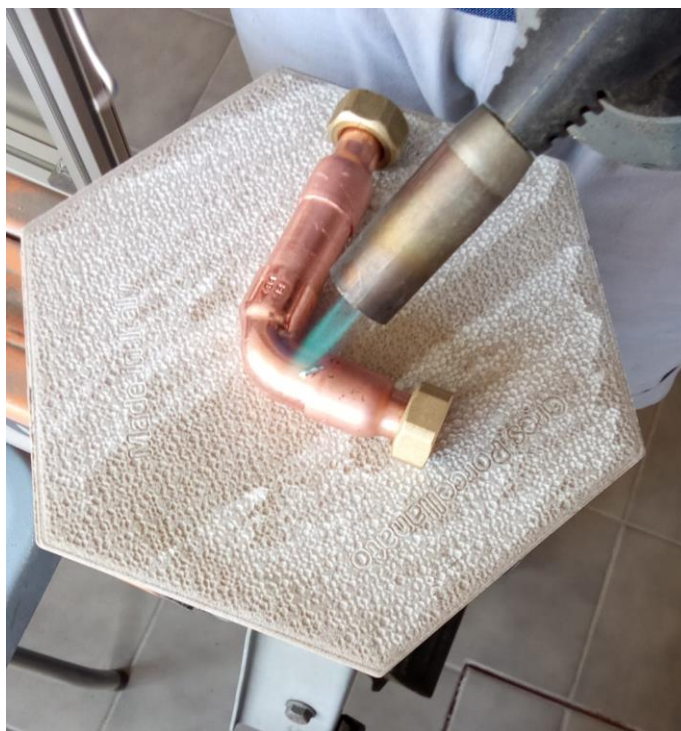
Figura 11 Pre calentamiento de la unión de cobre
