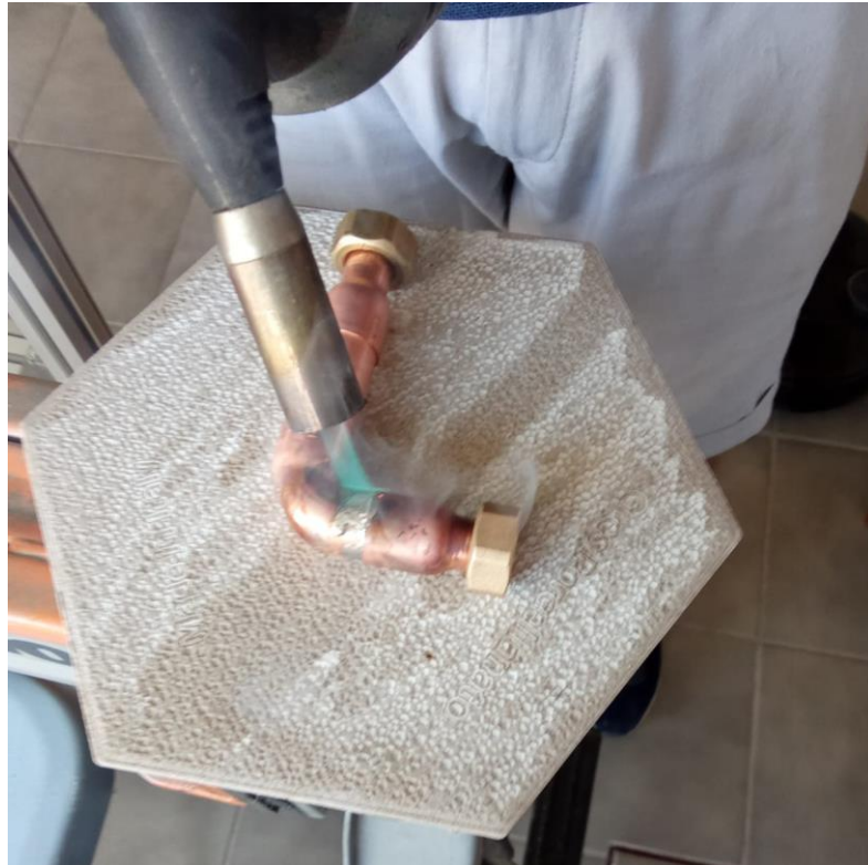
Figura 4.8 Soldadura completada
