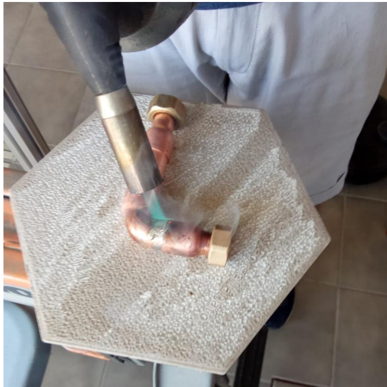
Figura 13 Soldadura completada
