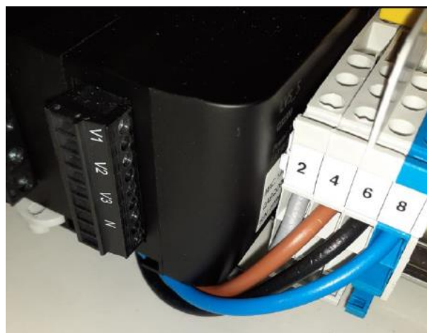
Figura 2.16 - Las 3 fases y el neutro
