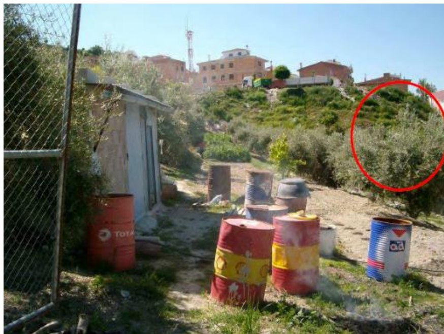
Figura 3.8 Talud excavado sobre terreno natural nº 1
