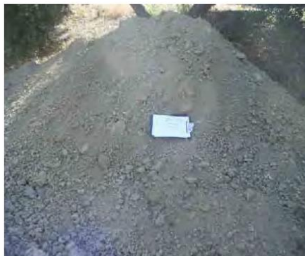
Figura 3.41 Fotografía de corte y material extraído de calicata CR-04
