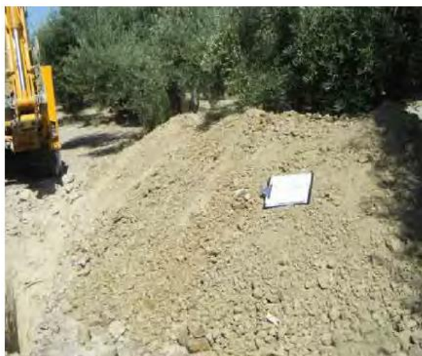
Figura 3.43 Fotografía de corte y material extraído de calicata CR-05
