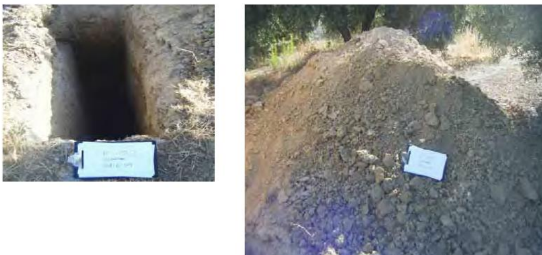
Figura 3.35 Fotografía de corte y material extraído de calicata CR-01
