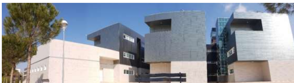
Figura 3.4. Vista fachada trasera. Fuente: Elaboración propia.
