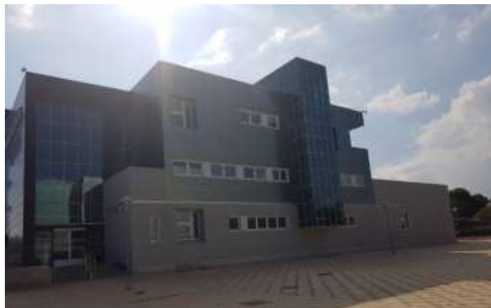
Figura 3.2. Vista fachada lateral derecha. Fuente: Elaboración propia.
