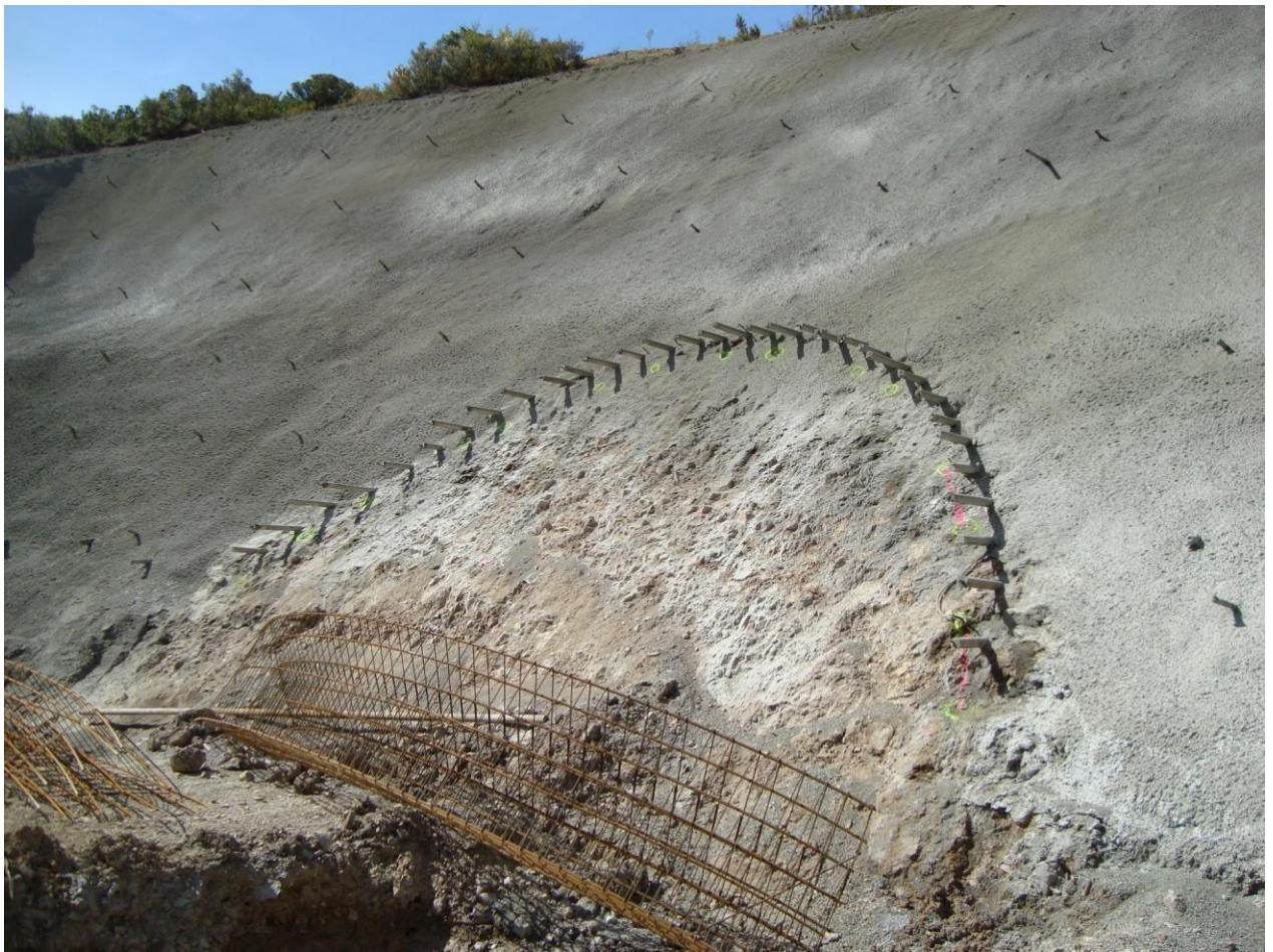
Figura 35. Paraguas de micropilotes 2
