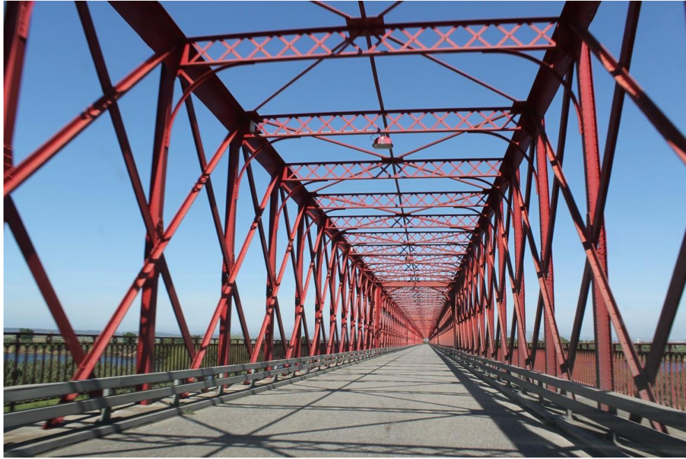
Ilustración 2-18: Puente de armadura de paso inferior. Fuente: https://pxhere.com/es/photo/624446
