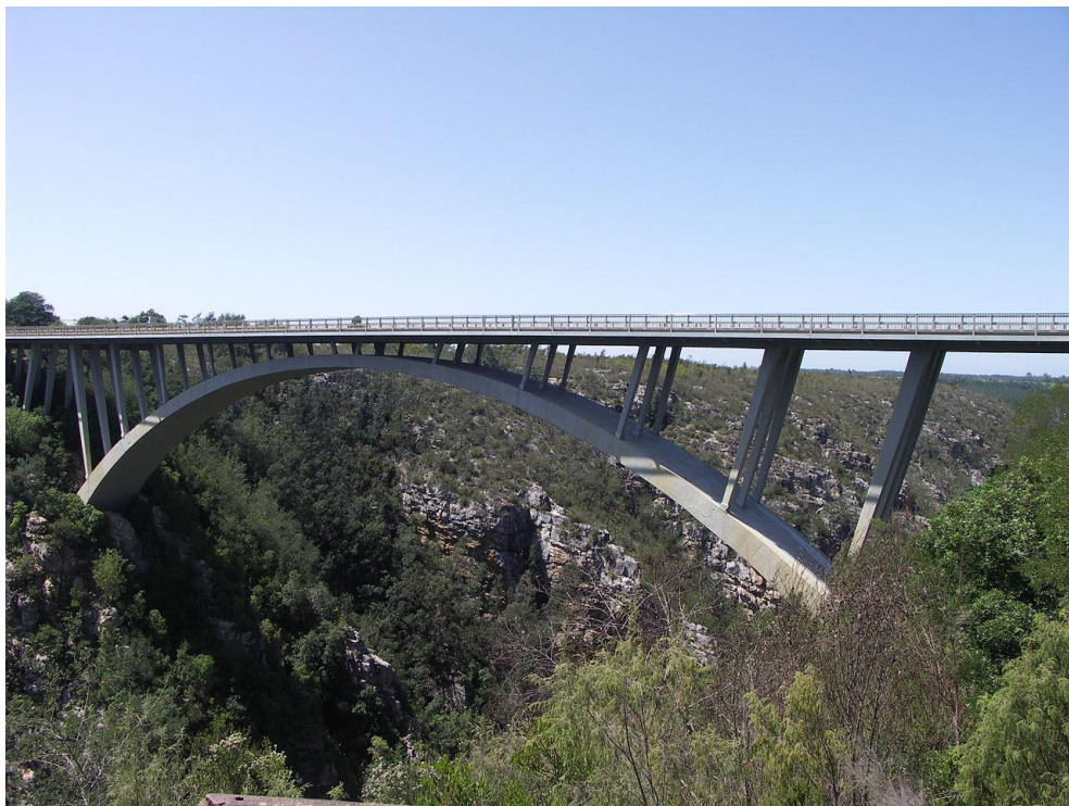
Ilustración 2-25: Puente de tablero. Puente Paul Sauer. Fuente: https://victoryepes.blogs.upv.es/
