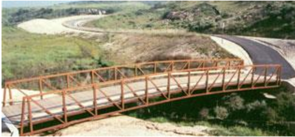
Ilustración 2-20: Puente de paso intermedio. Fuente: www.excelbridge.com/es/para-ingenieros/tipos-de-puentes
