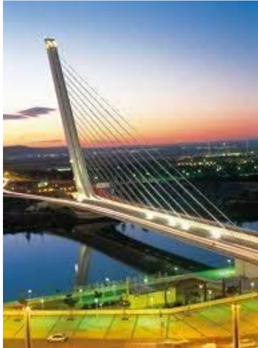
Ilustración 2-33: Puente atirantado Alamillo. Sevilla. Fuente: https://jose-yupanqui.blogspot.com
