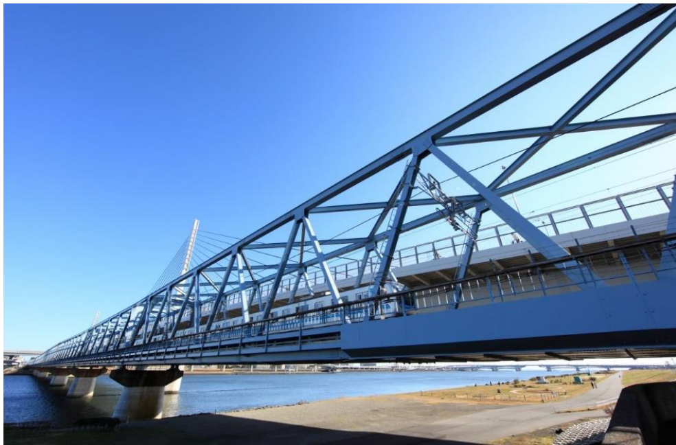
Ilustración 2-19: Puente de armadura de paso inferior. Fuente: https://pxhere.com/es/photo/582500
