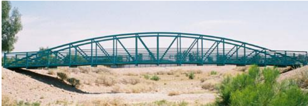
Ilustración 2-13: Viga Pratt. Fuente: www.excelbridge.com/es/para-propietarios/bridge-types-spanish
