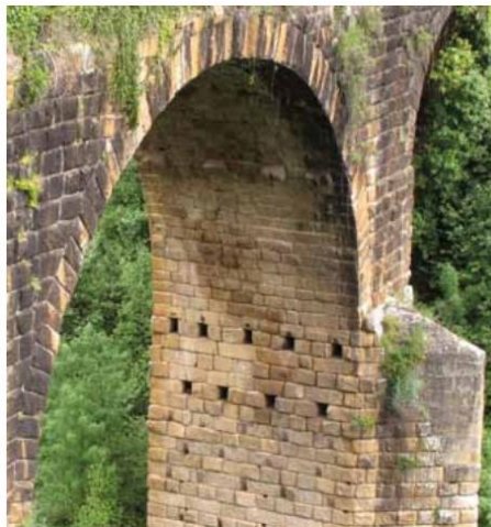
Ilustración 2-22: Apoyo de la cimbra y andamios. Fuente: Puentes arcos (I). Historia de los puentes arco. Revista de Obras Públicas.
