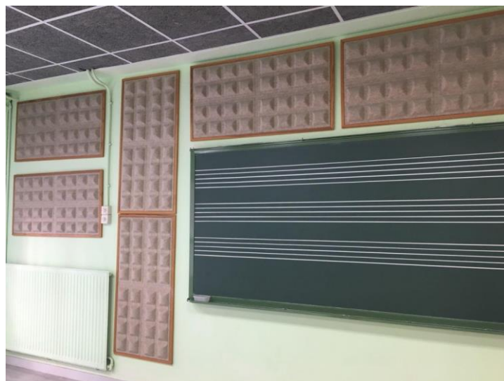
Ilustración 5. Ejemplo de insonorización acústica de un aula.
