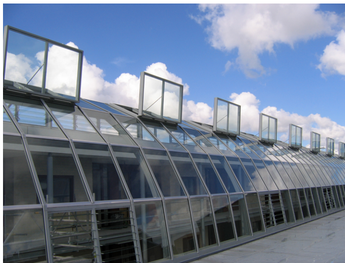
Ilustración 4.1. Edificio con aberturas y rejillas de ventilación.
