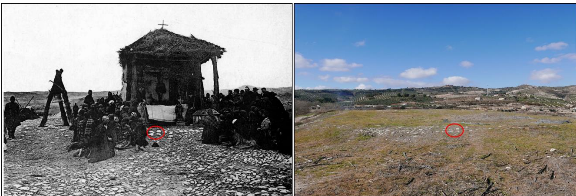
Figura 31. Comparativa de la foto de la iglesia provisional y el lugar actual.
