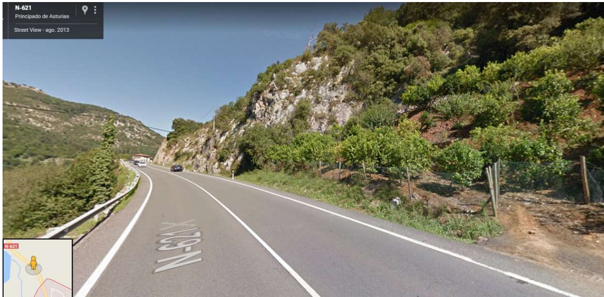
Figura 6. Boca sur del túnel
