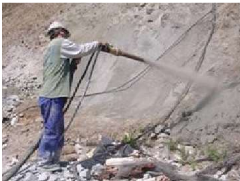
Figura 28. Hormigón proyectado en puntos específicos del talud
