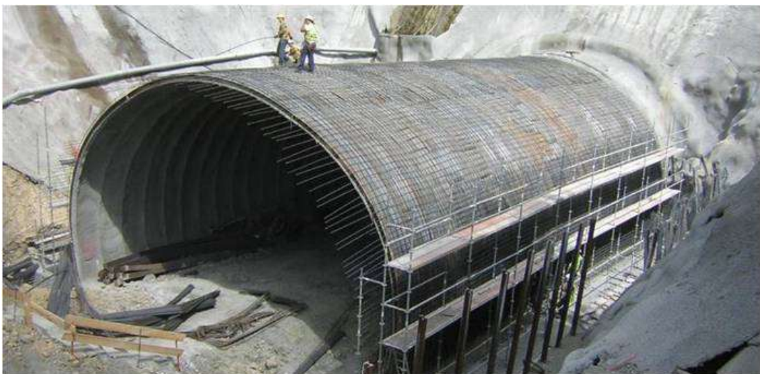
Figura 26. Paraguas de micropilotes 2
