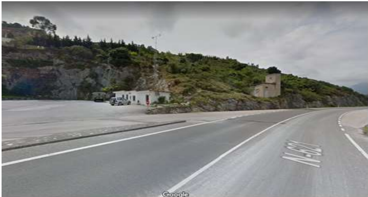
Figura 7. Boca norte del túnel
