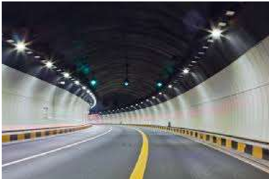
Figura 43. Iluminación del túnel
