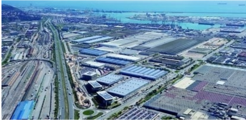
Ilustración 63. Polígono industrial en las inmediaciones del puerto de Barcelona.
