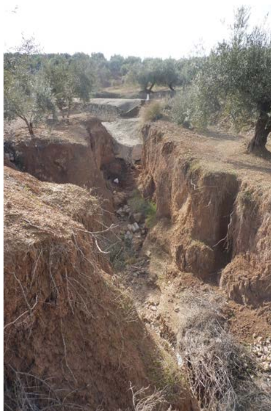
Figura 2: Drenaje superficial de cuneta perimetral de la carretera JV-3200, Torredelcampo (foto J. Calero, febrero 2017).
