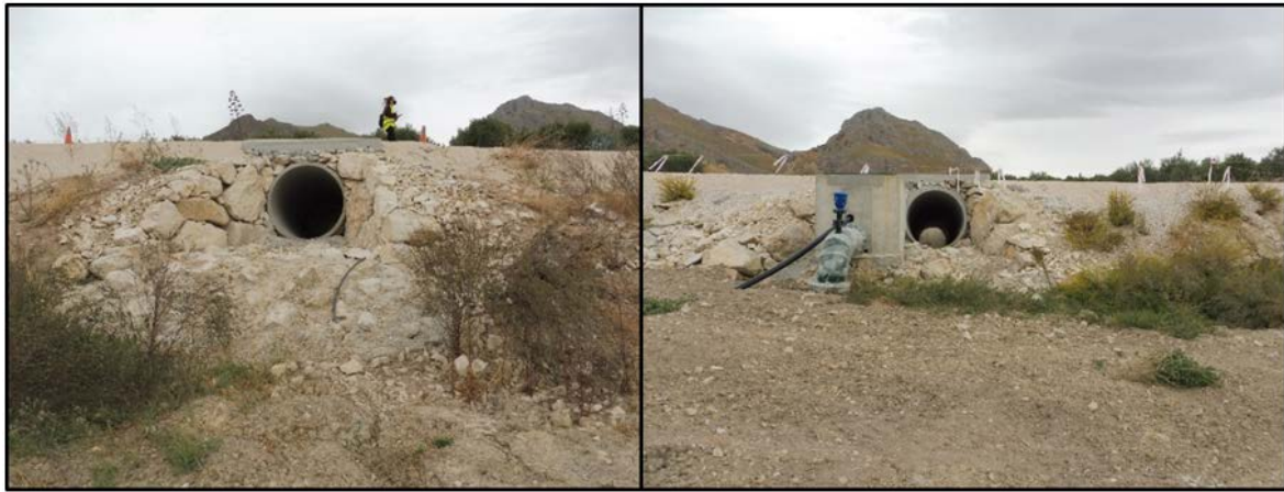
Figura 15: Obras de drenaje transversal en la zona de estudio 1, en el tramo de la carretera aún no inaugurado (foto J. Calero, octubre 2020).
