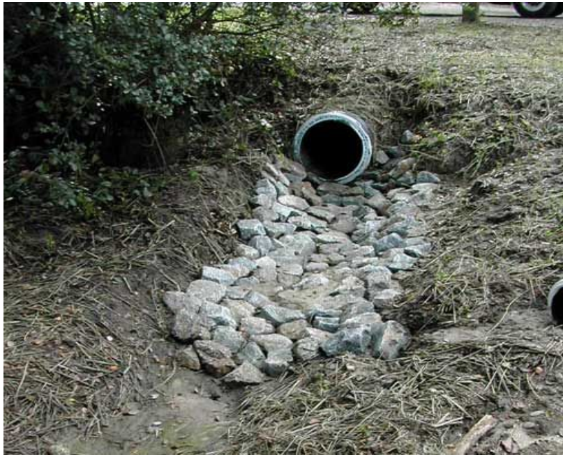
Figura 21: Ejemplo de un disipador tipo riprap en campo. Fuente: https://i.pinimg.com/originals/c4/e3/36/c4e33655596219e013b56a0b4f35048e.jpg
