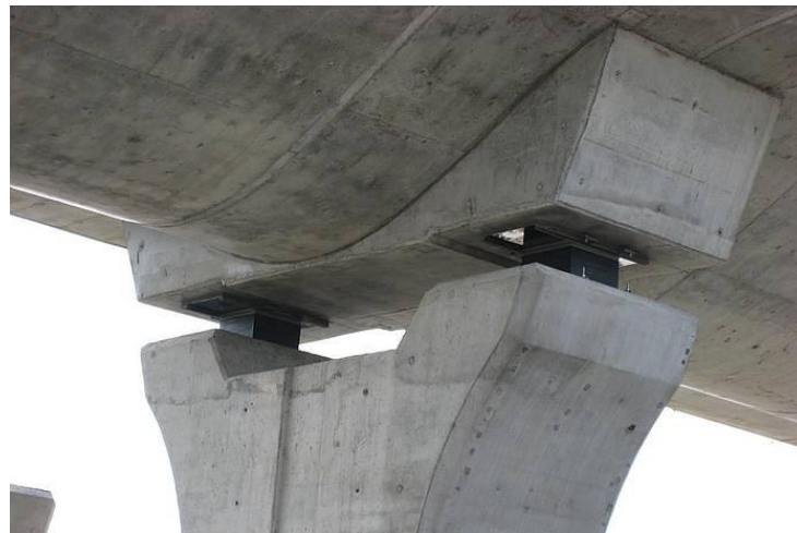
Figura 36. Detalle de los apoyos elastoméricos de un puente.
