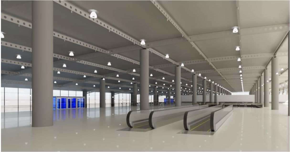
Figura 121. Cintas mecánicas en vestíbulo de salidas.
