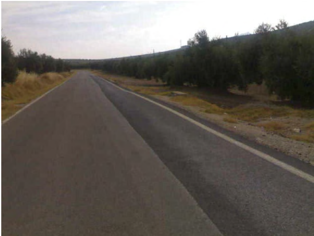
Figura 3. Reciente reparación del firme de la carretera
