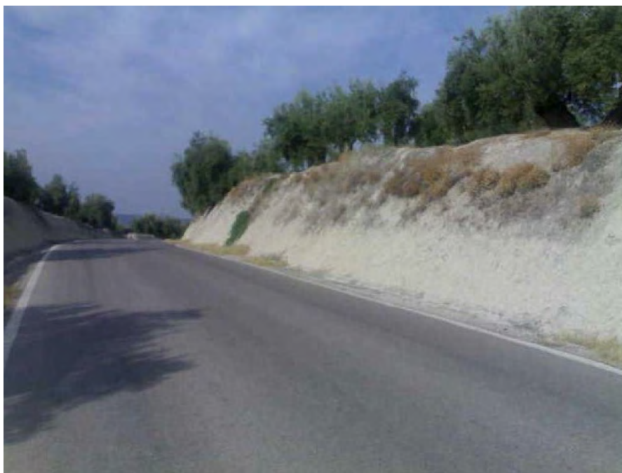
Figura 11. Talud excavado en la formación de margas blancas.
