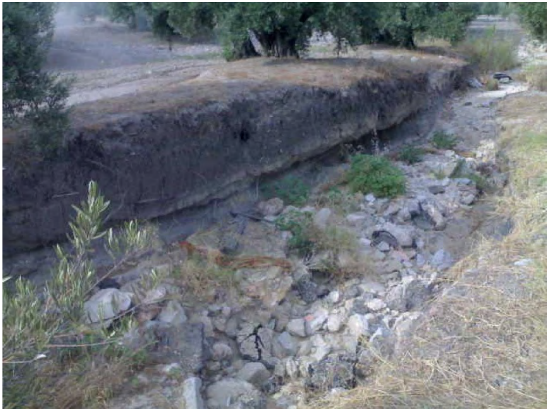
Figura 3. Vista de afloramiento natural de los rellenos de fondo de valle.
