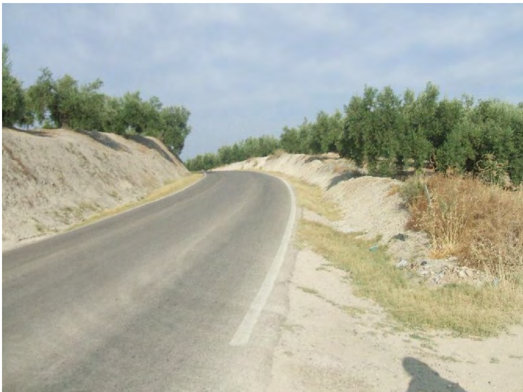
Figura 8. Vista de desmontes excavados en la formación de margas blancas (Mb).
