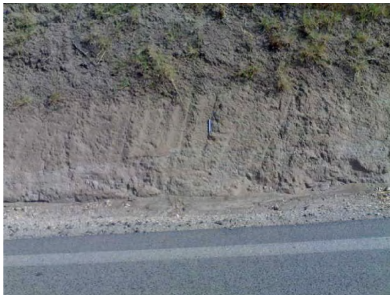
Figura 10. Depósitos aluviales constituidos por limos arcillosos de tonos marrones en desmonte.
