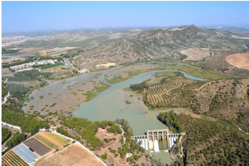
Fig 1.1. Embalse de Cordobilla, en el río Genil, lleno de lodos.
