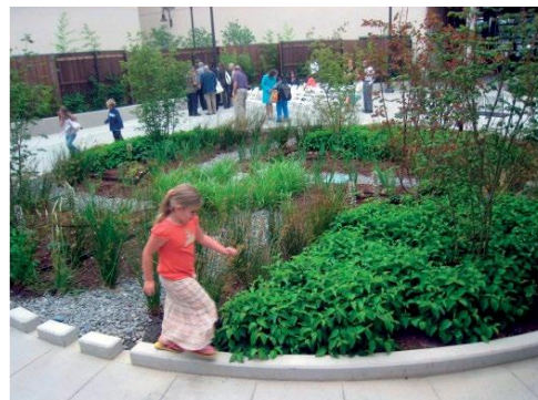
Cuenca de infiltración en campo abierto: Muy útiles para la eliminación de contaminantes y realizan pre-tratamiento del agua. Fuente: (Krauze and Wagner, 2014).
