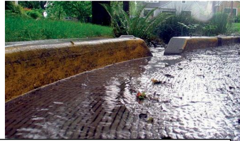
Ejemplo de una hendidura en la acera para canalizar el agua procedente de escorrentía de la vegetación, en Portland, E.E.U.U. Fuente: (Krauze and Wagner, 2014).
