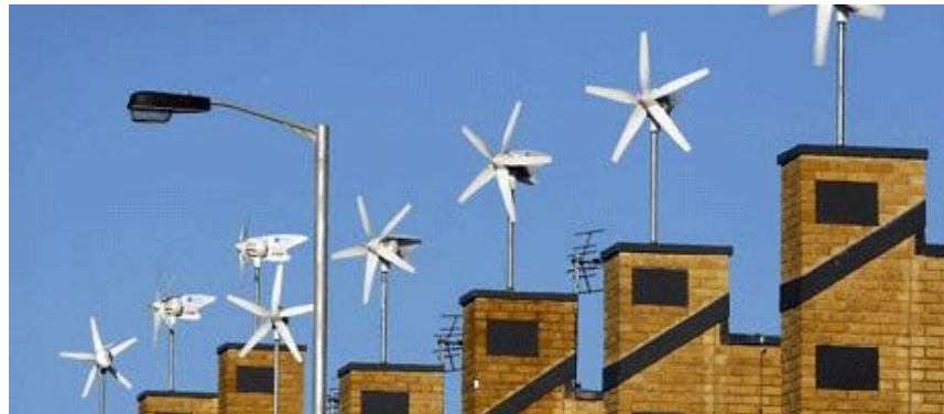
Figura 2.17. – Instalación doméstica eólica. Fuente [11]
