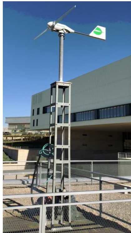
Figura 4.4 – Aerogenerador fijado en su estructura. Fuente propia.
