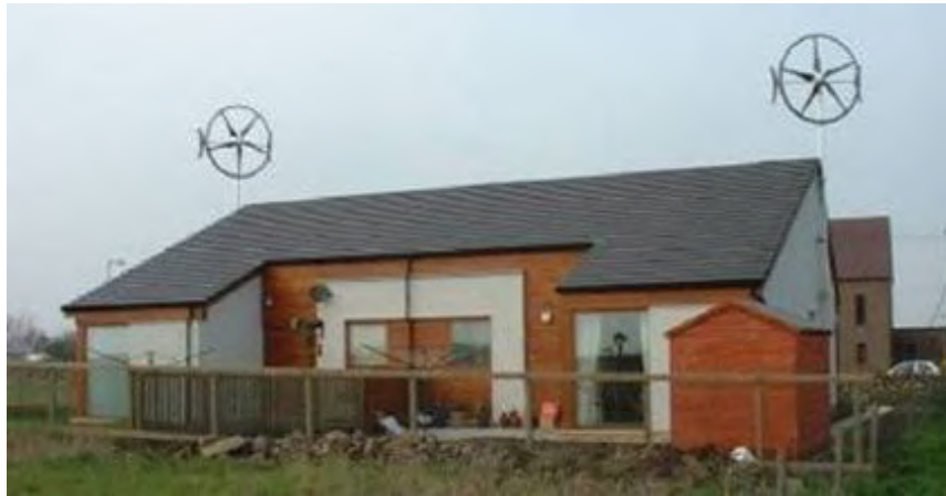
Figura 2.18. – Instalación domestica eólica. Fuente [11]
