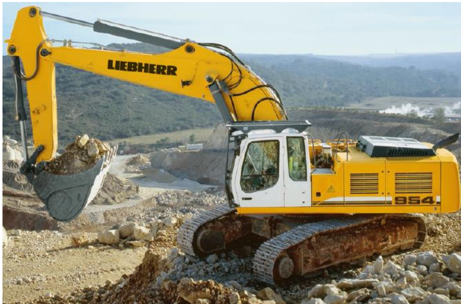
Foto 15: Excavadora de cadenas LIEBHERR 954
