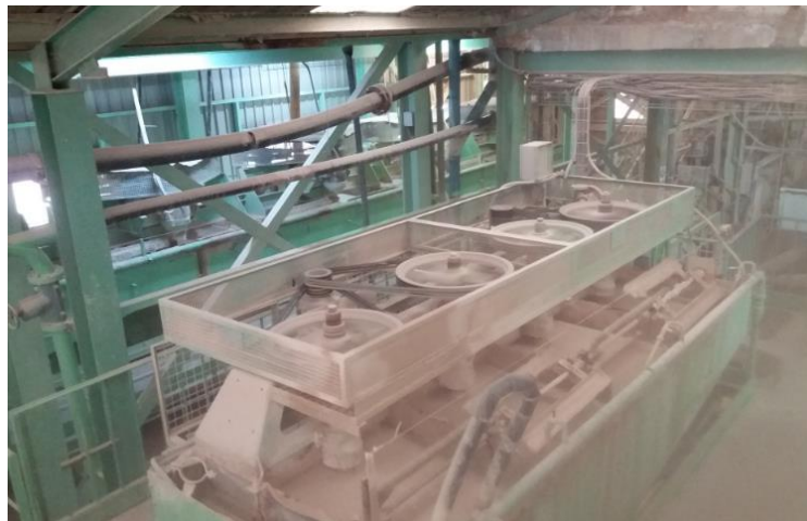
Foto 45: Batería de dos grupos bicelda
