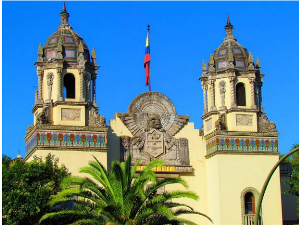
Foto 112. Torres del pabellón
