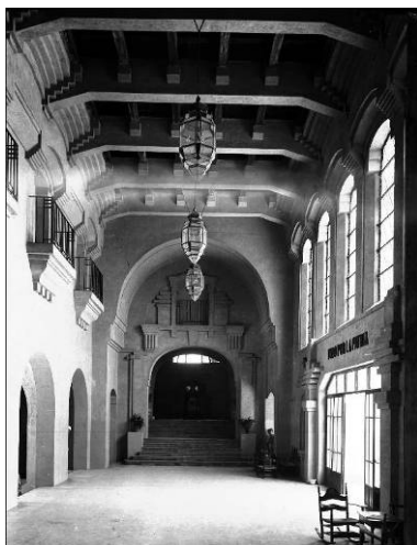
Foto 103. Vestíbulo y escaleras 1929
