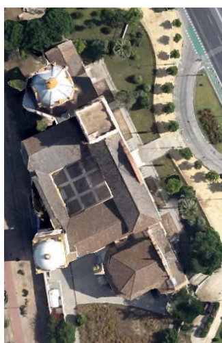
Foto 45. Vista aérea Pabellón Argentina
