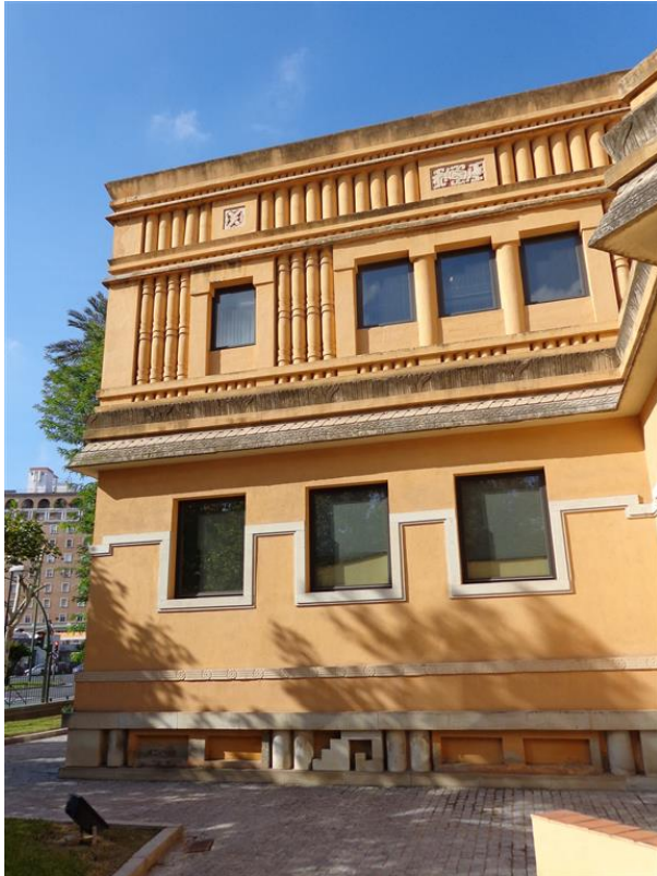
Foto 169. Fachada del pabellón
