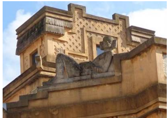
Foto 179. Remate fachada pabellón
