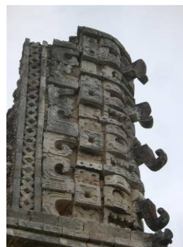
Foto 183. Remate fachada pabellón
