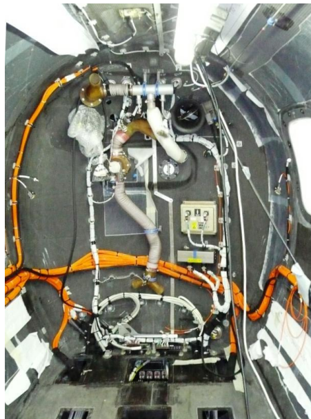
Figura 4.1 – Mamparo con sistemas instalados
