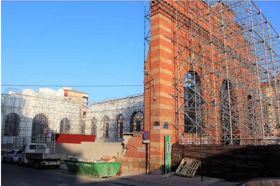
Imagen 4: Estado actual de la fachada principal y lateral SE.
