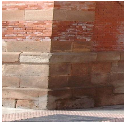
Imagen 12: Muro de fábrica de ladrillo.
