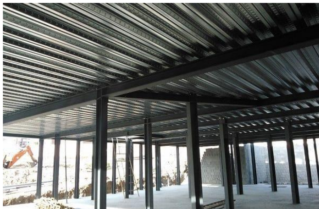
Imagen 30: Forjado de chapa colaborante.
