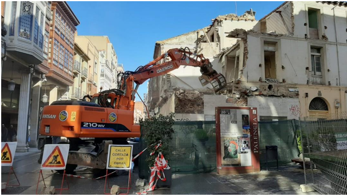
Imagen 28: Demolición con retroexcavadora.
