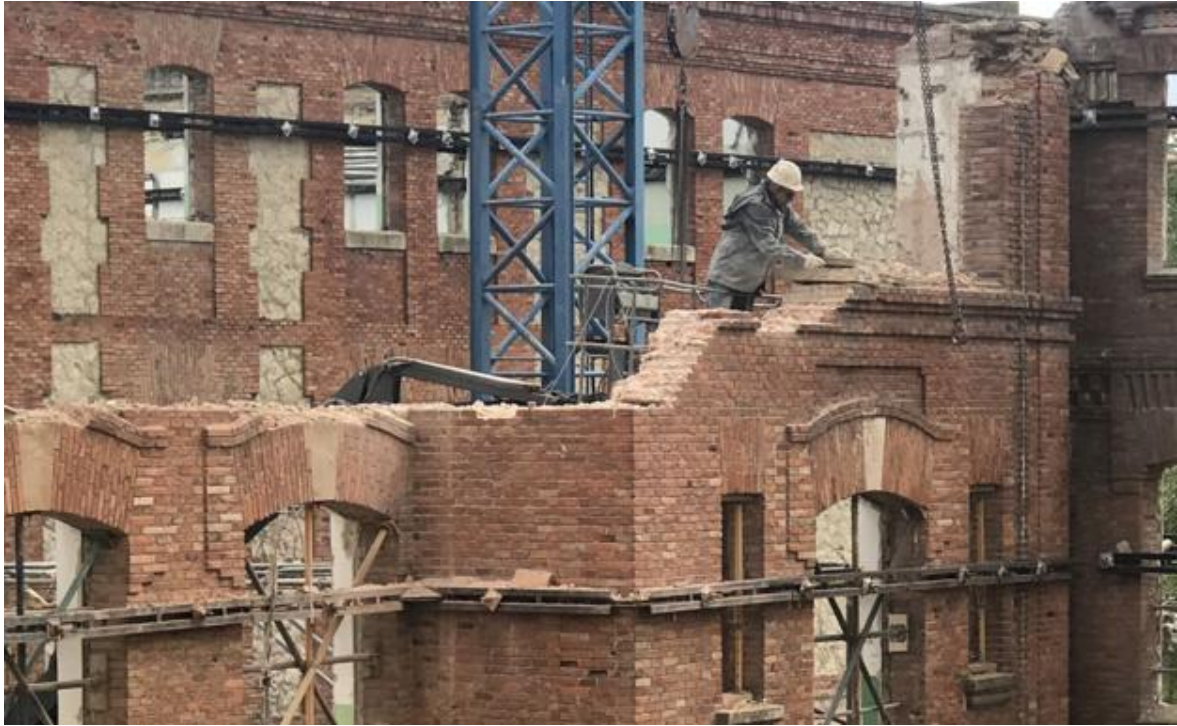
Imagen 29: Demolición por troceado de muros de ladrillo.
