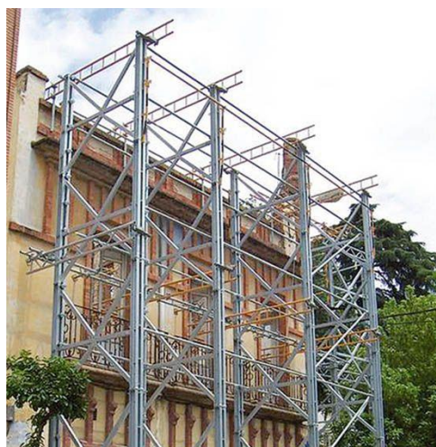
Imagen 21: Estabilización de la fachada.
