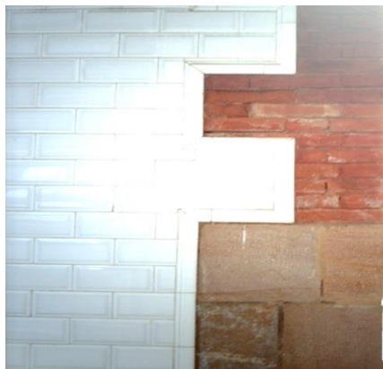
Imagen 13: Revestimiento de gres cerámico blanco.
