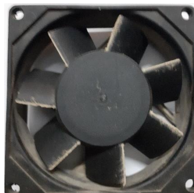
15. Ventilador sucio. Elaboración propia
