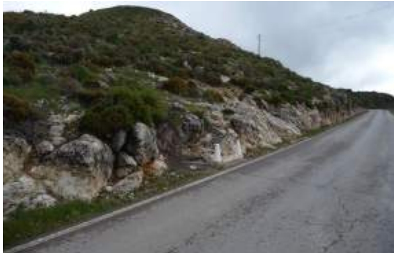
Fotografía 1 – Primeros metros de la actual carretera JA-3301.
