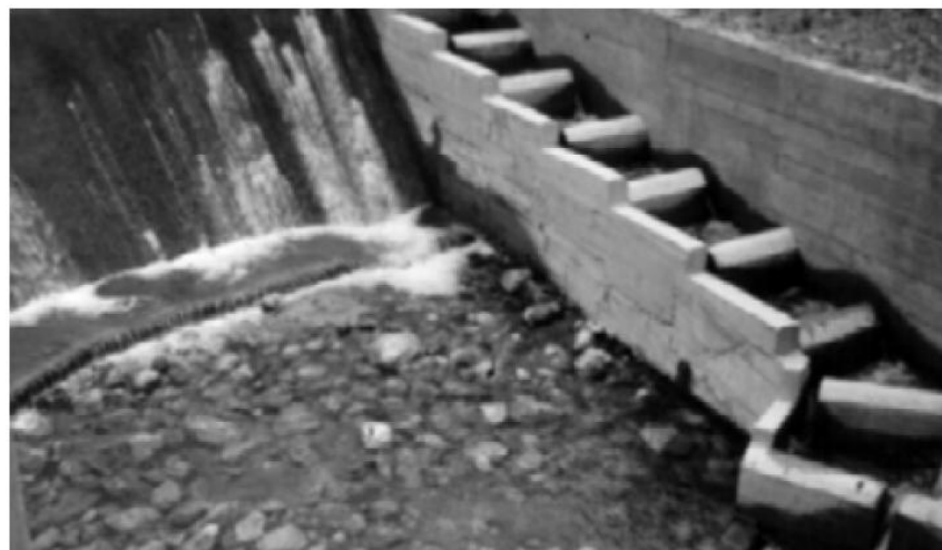
Figura 7.7 Escala con diafragmas con escotaduras verticales y orificios de fondo
