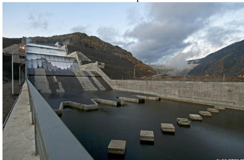
5.4 Fotografía de Cuenca disipador con bloques de hormigón
