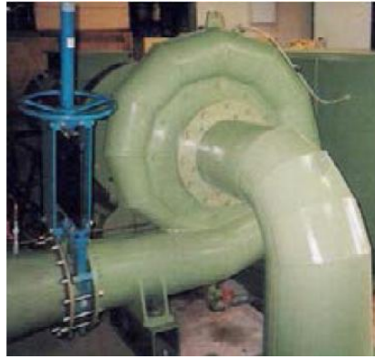
Figura 6.9 Fotografía de la carcasa de una turbina Francis
