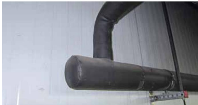
Figura 6. Recubrimiento de una tubería
