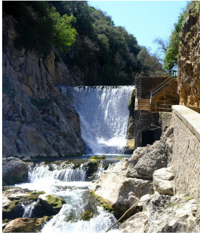
Ilustración 3 Azud de la Cerrada del Utrero (Elaboración propia)
