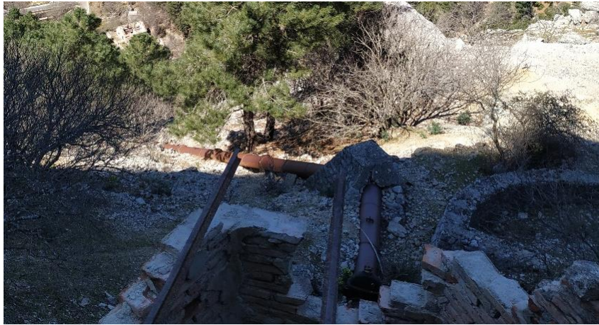
Ilustración 20 Chimenea de equilibrio Central Cerrada del Utrero (Elaboración propia)
