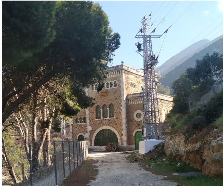
Ilustración 19 Edificio de la central del Gaitanejo en el río Guadalhorce (Elaboración propia)
