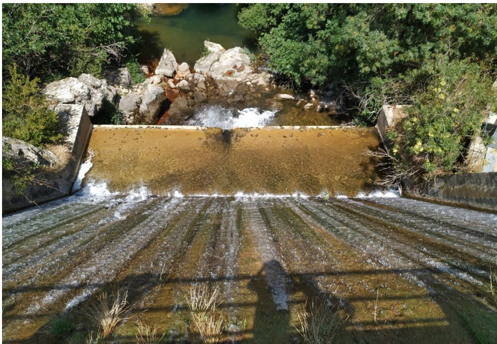
Ilustración 21 Aliviadero del embalse Aguas Negras en el río Borosa (Elaboración propia)
