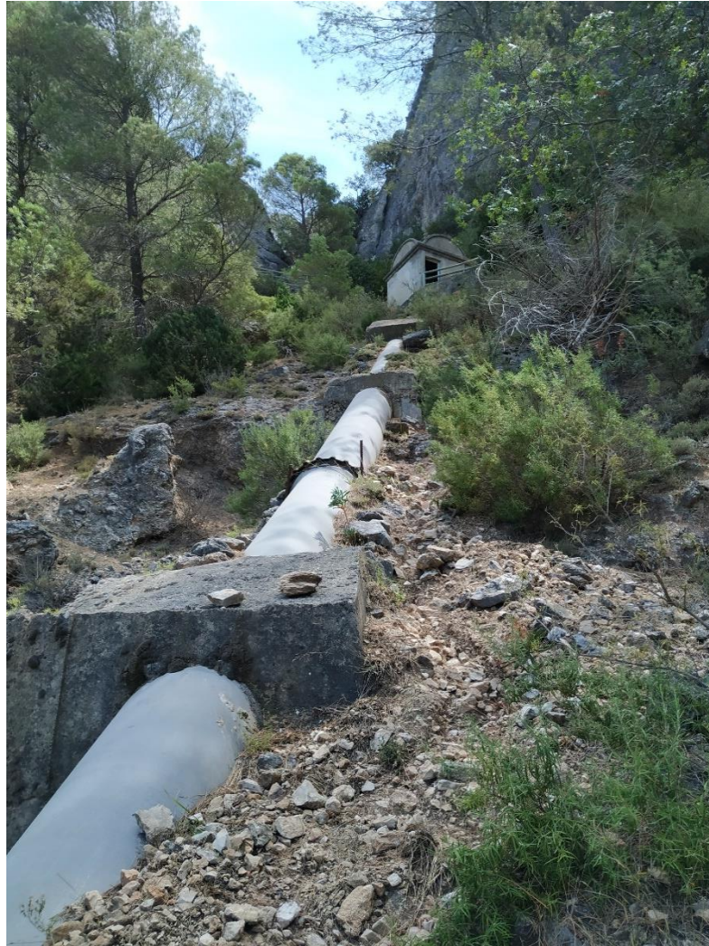
Ilustración 9 Tubería forzada en sierra de Cazorla (Elaboración propia)
