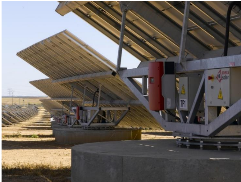
Figura 11-Estructura con seguimiento a 1 eje (Azimutal)
