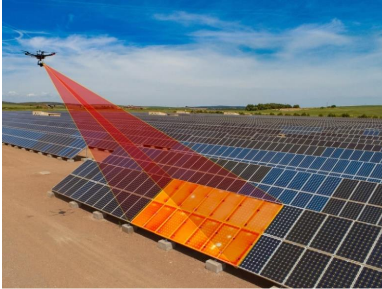
Figura 20-Dron haciendo una inspección en una planta fotovoltaica
