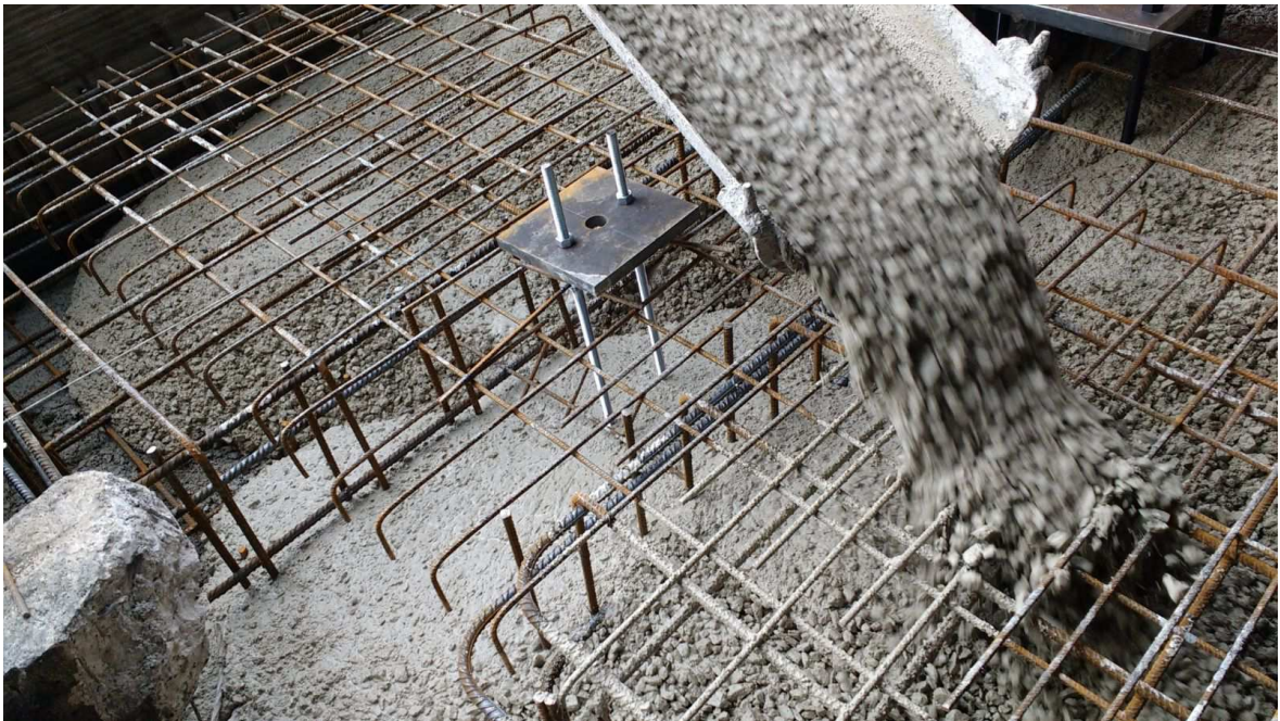
FIGURA: 4.2. Introducción de hormigón HA.
