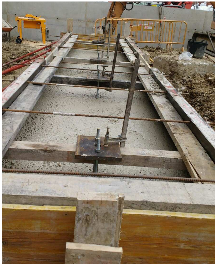
FIGURA: 4.4. Colocación de placas de anclaje y encofrado de la cimentación.
