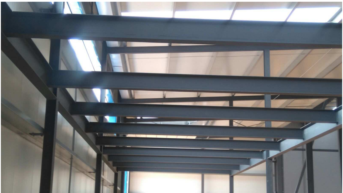
FIGURA: 4.6. Armazón estructural de la oficina.
