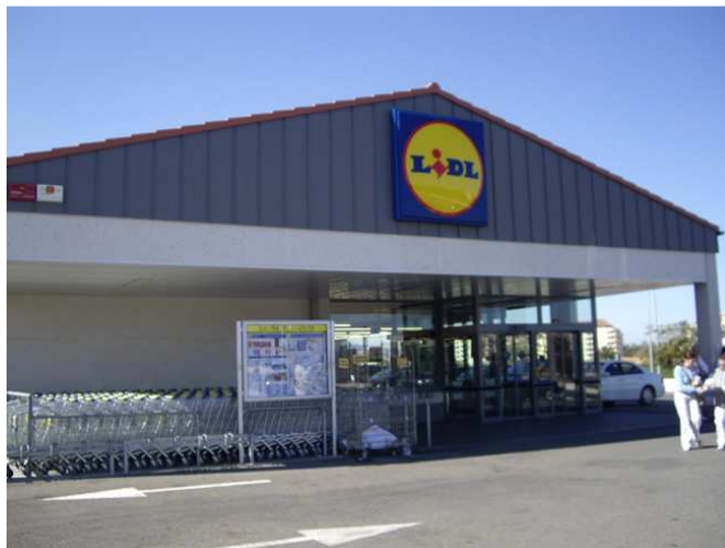
FIGURA: 1.2. Uso variado de las naves industriales como supermercados.
