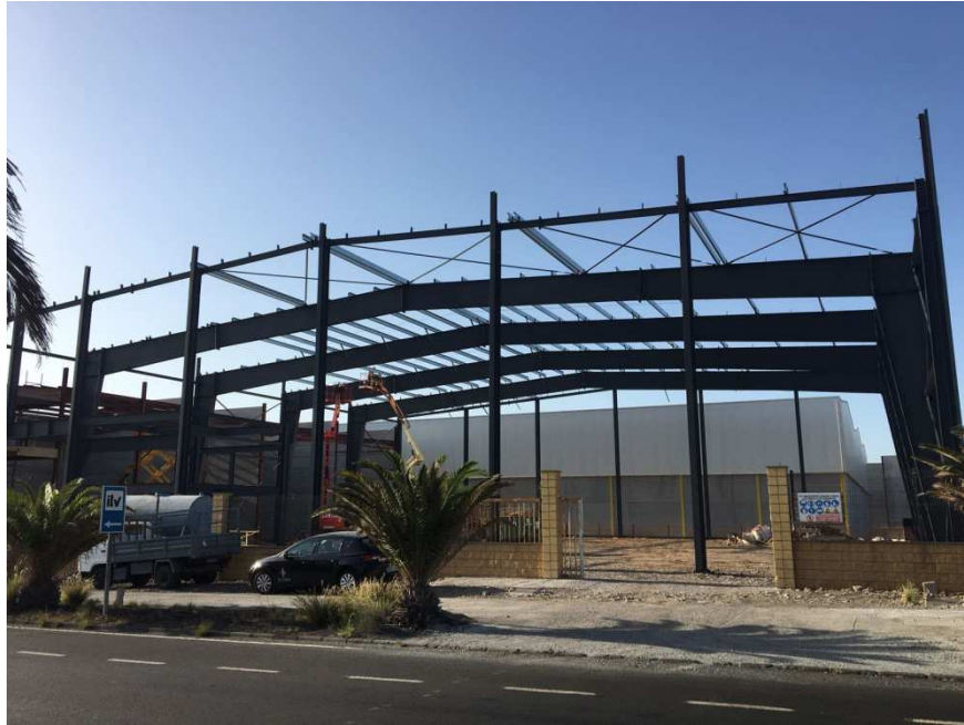
FIGURA: 4.11. Pórticos colocados en situación.
