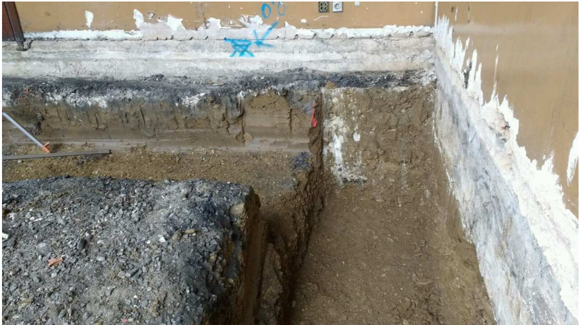
FIGURA: 4.1. Zanjas para las vigas de atado.
