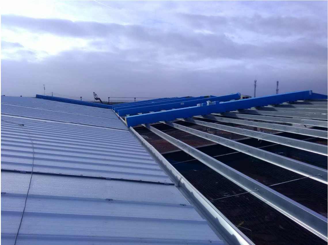
FIGURA: 4.7. Correa de cubierta.
