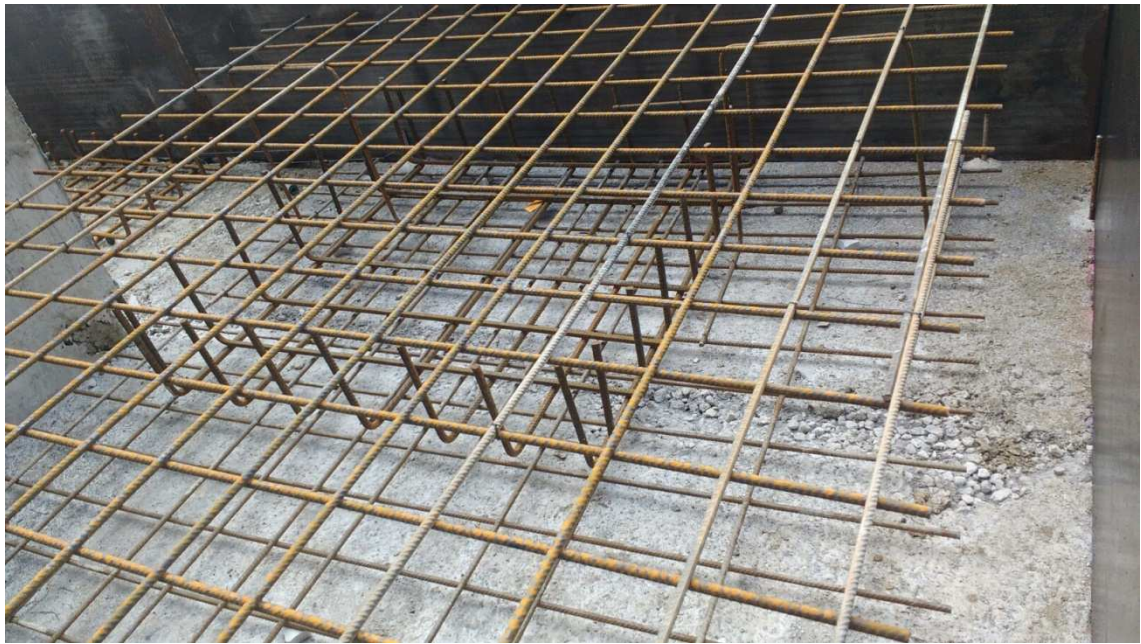
FIGURA: 4.3. Forjado para cimentación.
