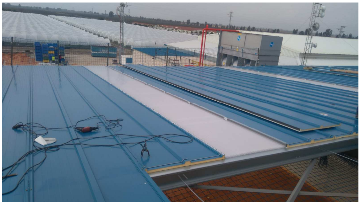
FIGURA: 4.12. Colocación de paneles sándwich.
