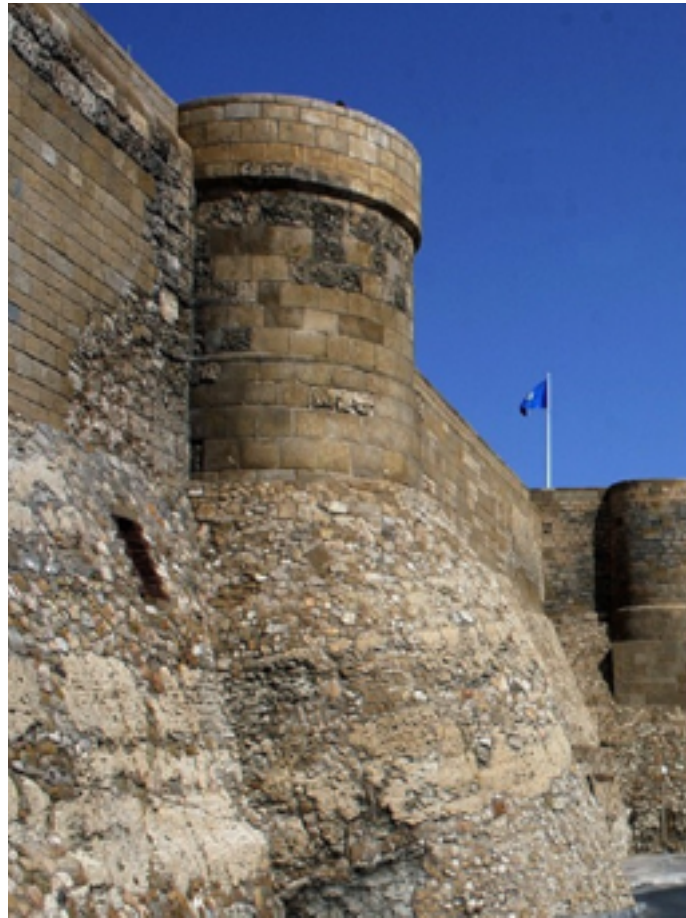
Fig. 12: Alambor del Torreón de Bernal Francés. Murallas Real. Melilla, siglo XVI. Recuperado de: https://www.glosarioarquitectonico.com/glossary/alambor/
