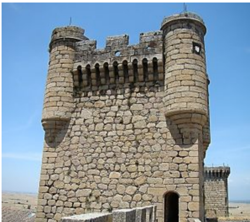
Fig. 15: Matacán y Escaraguaita. Recuperado de: https://www.glosarioarquitectonico.com/glossary/escaraguaita/
