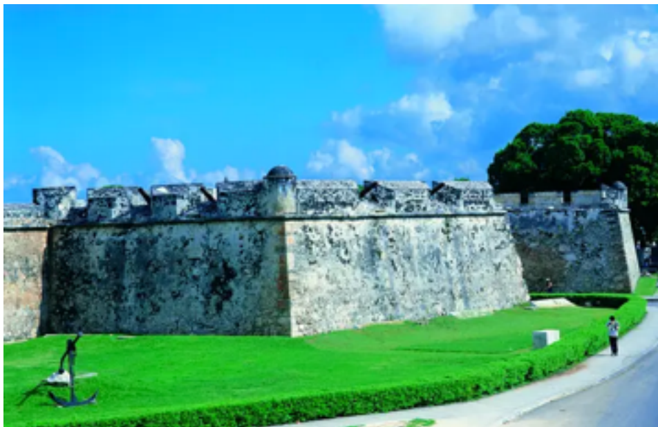
Fig. 13: Baluarte de San Francisco, Justo Sierra, México. Recuperado de: https://www.minube.com/rincon/baluarte-de-san-francisco--a123991
