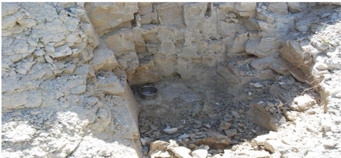
Fig. 4.8. Ejemplo de calicata abierta en el talud para toma de muestras.
