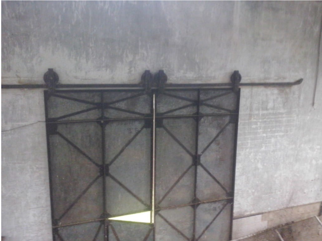
Imagen 2.4.5. Sala de máquinas. Fuente: Estudio de viabilidad de minicentrales provincia de Jaén. AGENER-Universidad de Jaén
