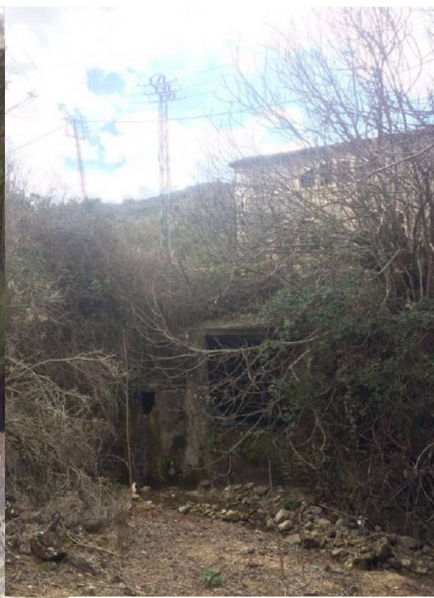
Imagen 2.4.54. Desagüe de la central. Desembocadura del desagüe y edificio de la central. Fuente: Estudio de viabilidad de minicentrales provincia de Jaén. AGENER-Universidad de Jaén
