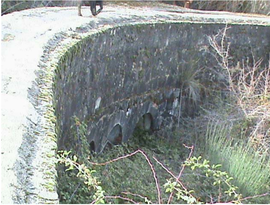
Imagen 2.4.22. Canal. Parte suspendida del canal. Fuente: Estudio de viabilidad de minicentrales provincia de Jaén. AGENER-Universidad de Jaén
