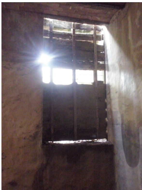
Imagen 2.4.30. Cámara de carga, Compuerta acceso cámara de carga. Fuente: Estudio de viabilidad de minicentrales provincia de Jaén. AGENER-Universidad de Jaén
