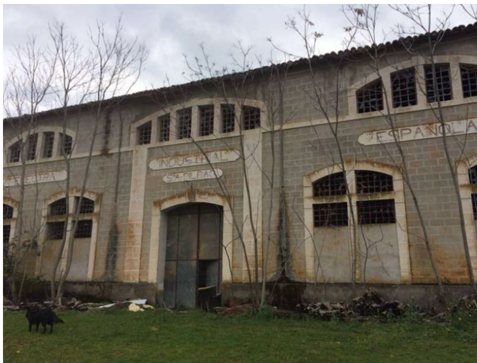
Imagen 2.4.1. Sala de máquinas. Fuente: Estudio de viabilidad de minicentrales provincia de Jaén. AGENER-Universidad de Jaén
