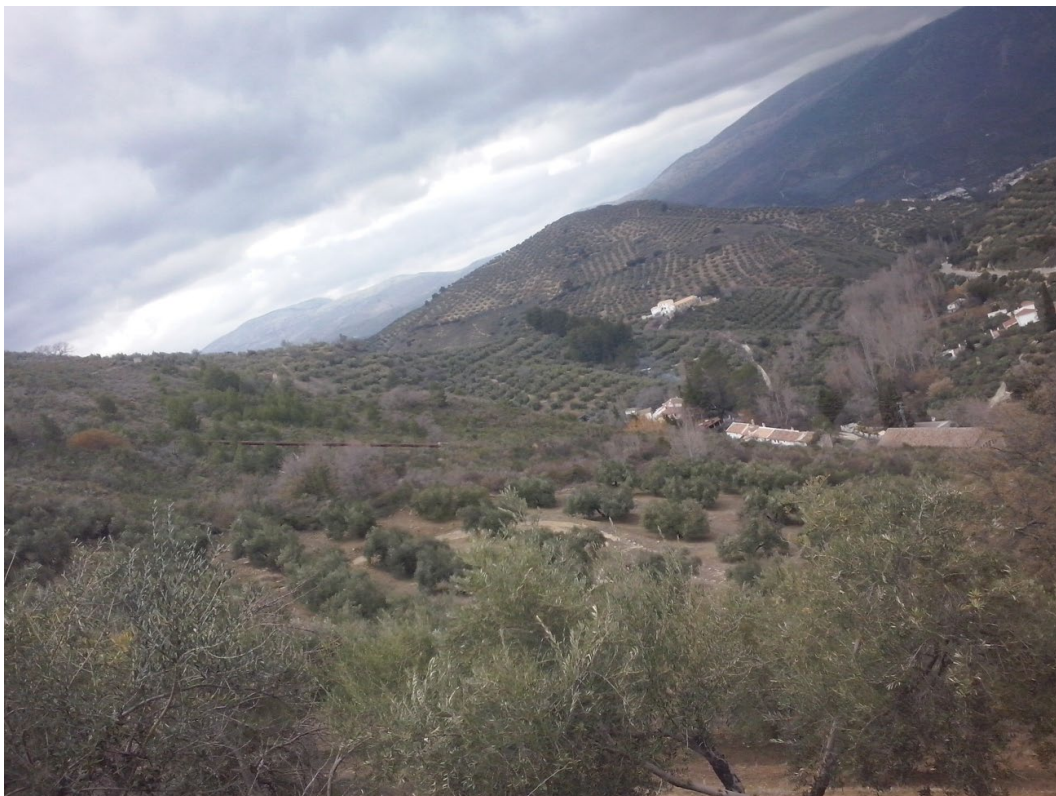
Imagen 2.4.37. Tubería forzada, Tubería forzada y edificio de central. Fuente: Estudio de viabilidad de minicentrales provincia de Jaén. AGENER-Universidad de Jaén
