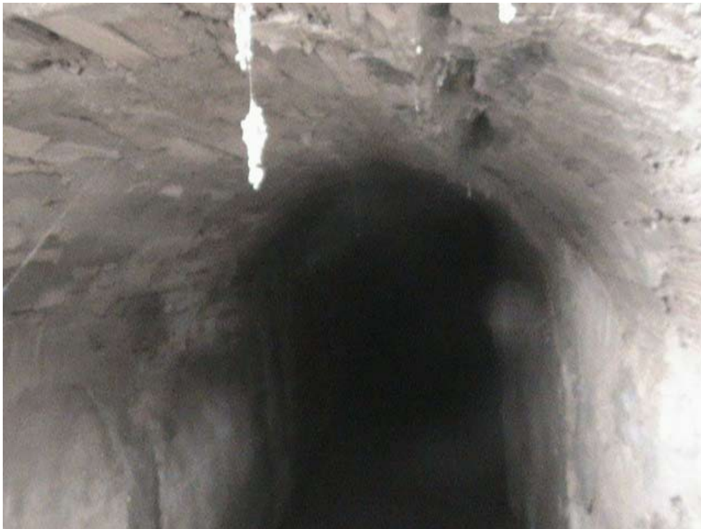
Imagen 2.4.21. Canal. Interior de canal desde chimenea. Fuente: Estudio de viabilidad de minicentrales provincia de Jaén. AGENER-Universidad de Jaén
