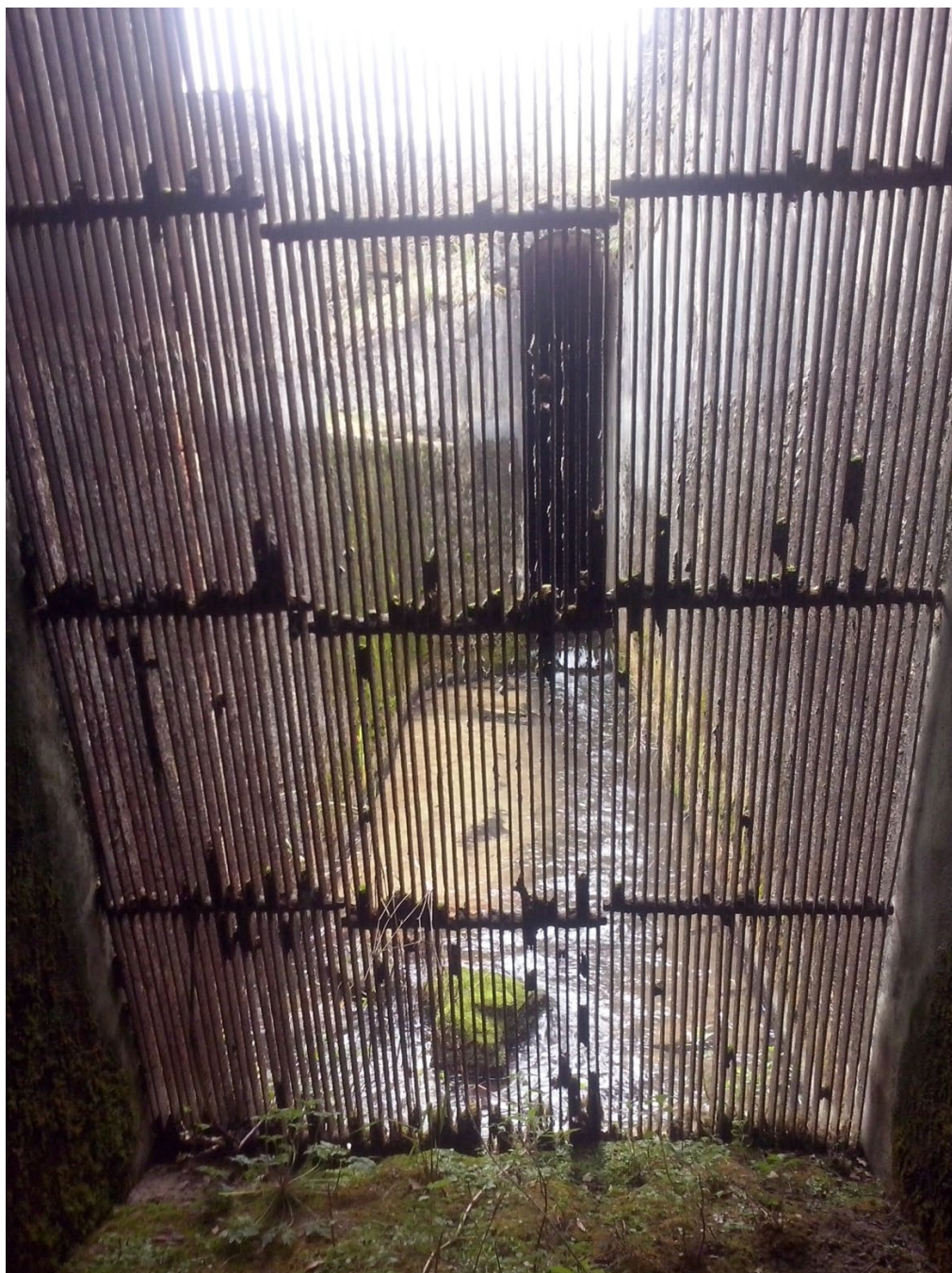
Imagen 2.4.45. Rejilla de la cámara de carga. Fuente: Estudio de viabilidad de minicentrales provincia de Jaén. AGENER-Universidad de Jaén
