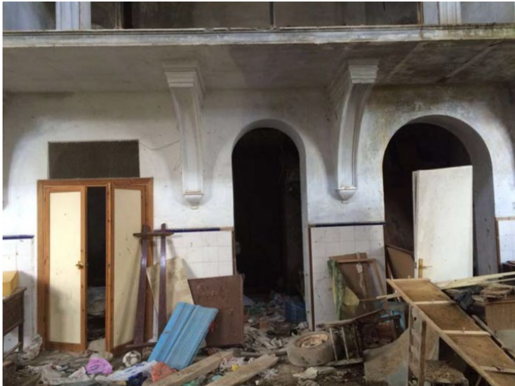
Imagen 2.4.6. Sala de máquinas. Fuente: Estudio de viabilidad de minicentrales provincia de Jaén. AGENER-Universidad de Jaén
