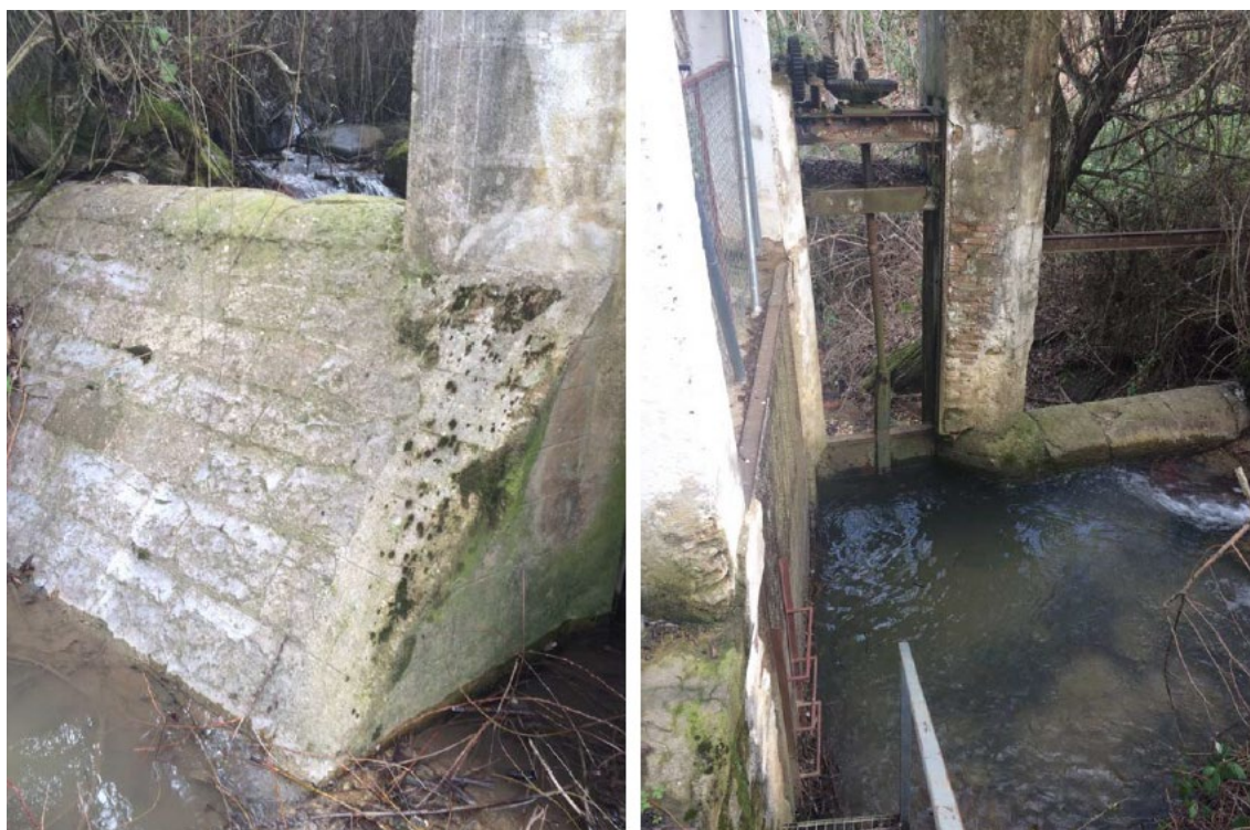
Imagen 2.4.19. Azud. Fuente: Estudio de viabilidad de minicentrales provincia de Jaén. AGENER-Universidad de Jaén
