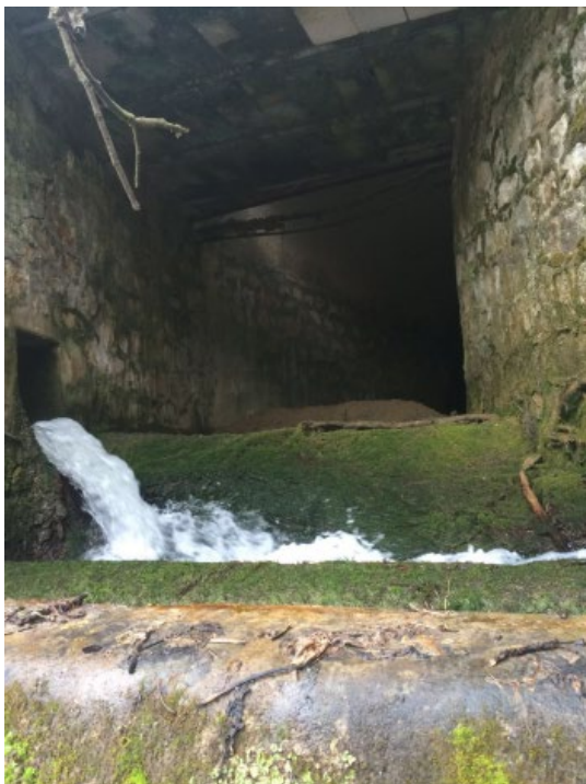
Imagen 2.4.52. Desagüe de la central. Desembocadura del desagüe. Fuente: Estudio de viabilidad de minicentrales provincia de Jaén. AGENER-Universidad de Jaén
