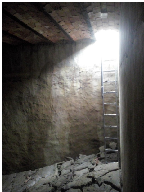
Imagen 2.4.33. Cámara de carga, Acceso interior cámara de carga. Fuente: Estudio de viabilidad de minicentrales provincia de Jaén. AGENER-Universidad de Jaén
