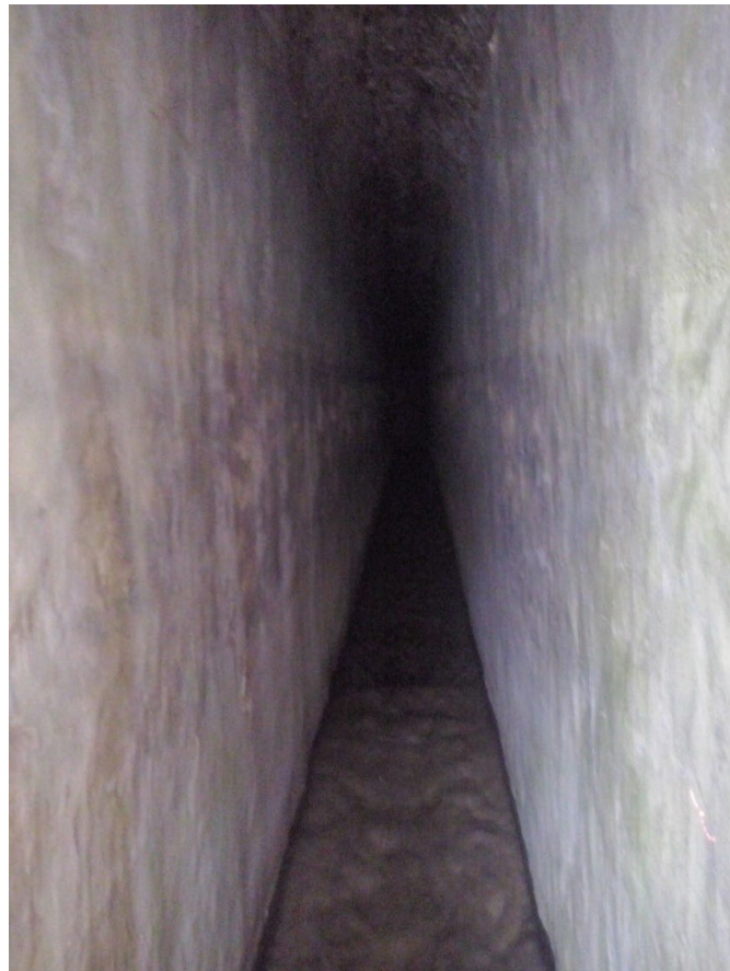
Imagen 2.4.27. Canal, Interior del canal cerca de la desembocadura. Fuente: Estudio de viabilidad de minicentrales provincia de Jaén. AGENER-Universidad de Jaén
