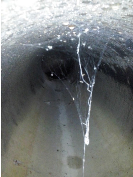
Imagen 2.4.34. Tubería forzada, Interior tubería forzada. Fuente: Estudio de viabilidad de minicentrales provincia de Jaén. AGENER-Universidad de Jaén
