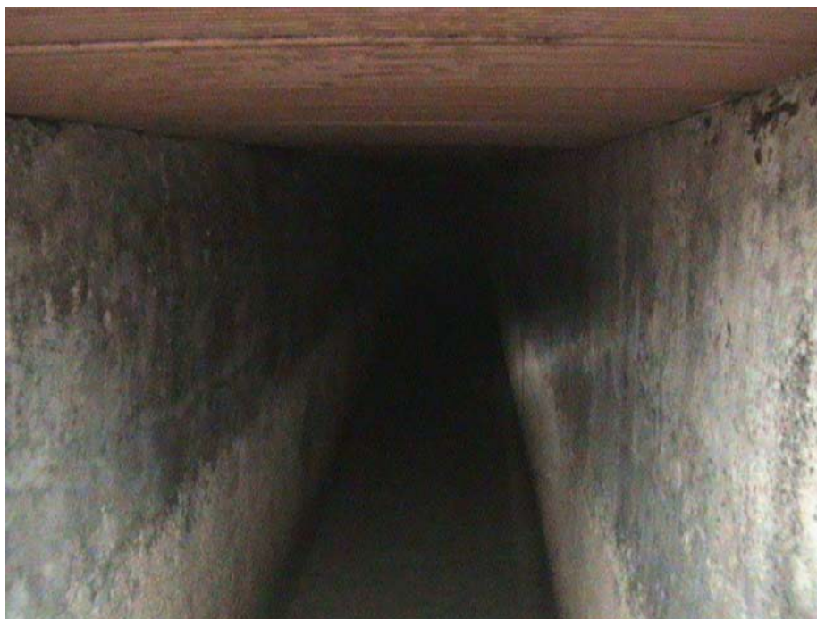
Imagen 2.4.24. Canal, Interior parte cubierta reparada del canal. Fuente: Estudio de viabilidad de minicentrales provincia de Jaén. AGENER-Universidad de Jaén
