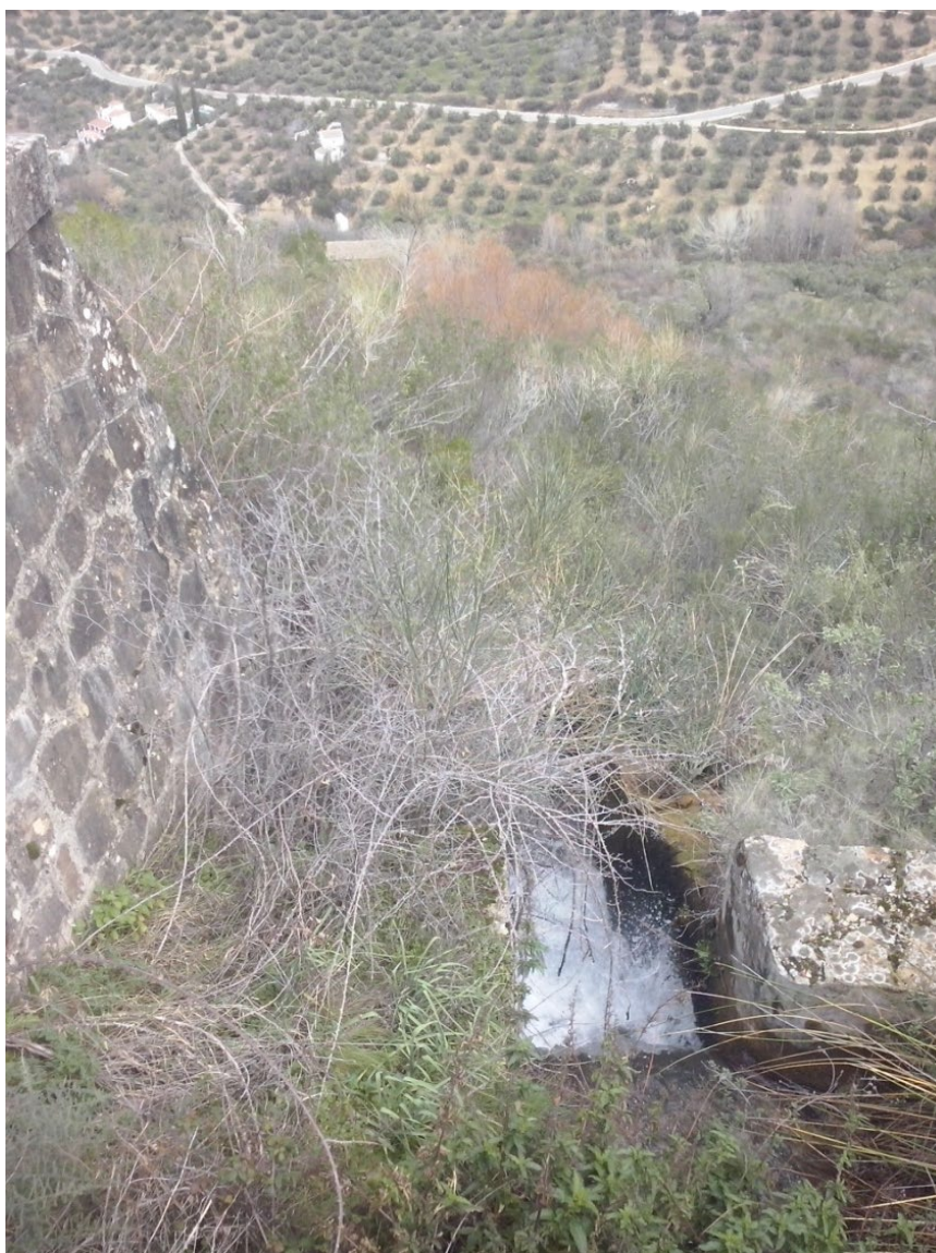
Imagen 2.4.46. Canal aliviadero. Inicio del canal aliviadero. Fuente: Estudio de viabilidad de minicentrales provincia de Jaén. AGENER-Universidad de Jaén
