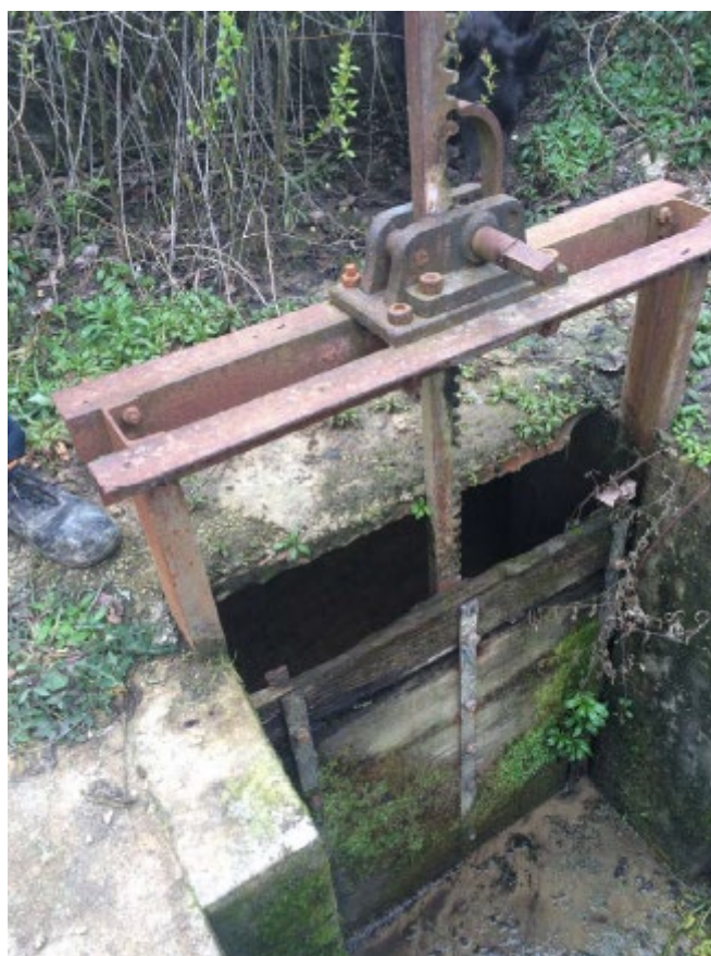
Imagen 2.4.40. Compuerta del vaciado del canal. Fuente: Estudio de viabilidad de minicentrales provincia de Jaén. AGENER-Universidad de Jaén
