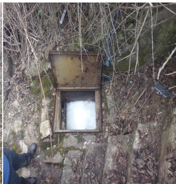
Imagen 2.4.48. Canal aliviadero. Parte subterránea del canal aliviadero. Fuente: Estudio de viabilidad de minicentrales provincia de Jaén. AGENER-Universidad de Jaén.
