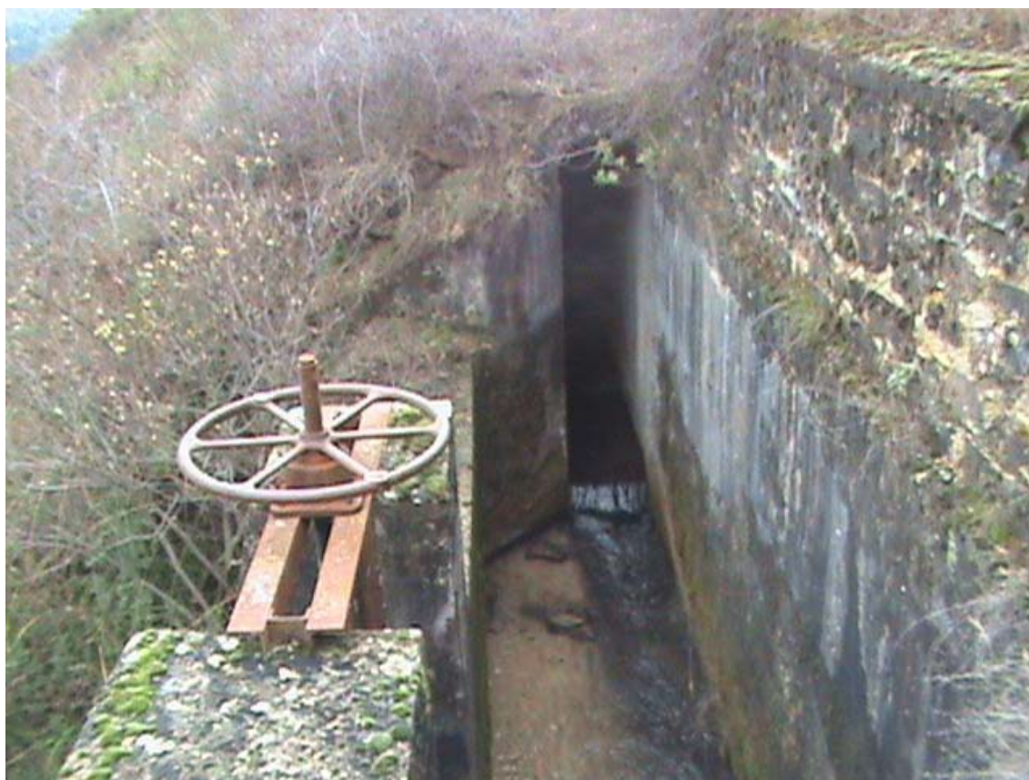
Imagen 2.4.29. Canal, Desembocadura del canal. Fuente: Estudio de viabilidad de minicentrales provincia de Jaén. AGENER-Universidad de Jaén
