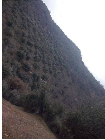
Imagen 2.4.35. Tubería forzada. Fuente: Estudio de viabilidad de minicentrales provincia de Jaén. AGENER-Universidad de Jaén.
