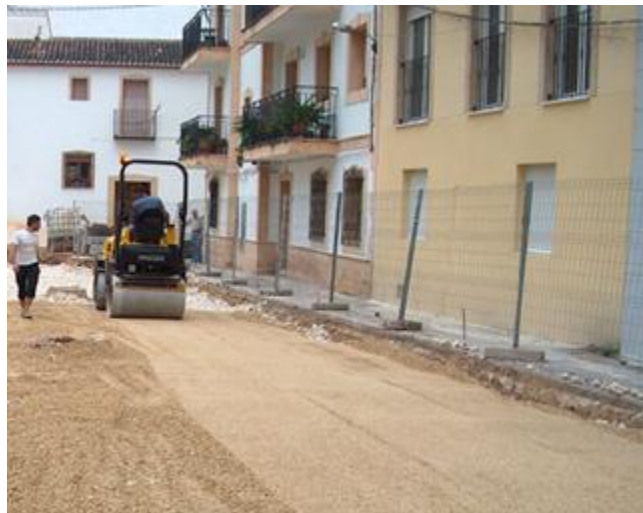
Figura 1.6: Base de zahorra. ( http://www.excavaciones-mayte.com/obra-civil.html )
