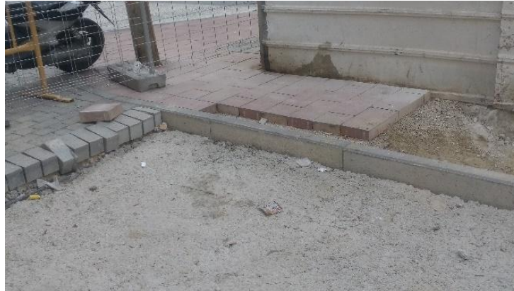
Figura 1.6: Base de zahorra. ( http://www.excavaciones-mayte.com/obra-civil.html )
