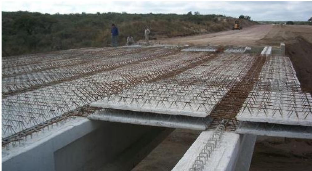
Figura 2.7. Prelosas colaborantes con armadura de cosido [6]
