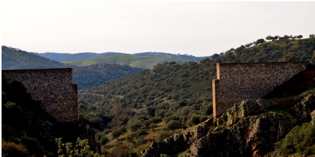
Figura 2.3 Ubicación real de la estructura [2]
