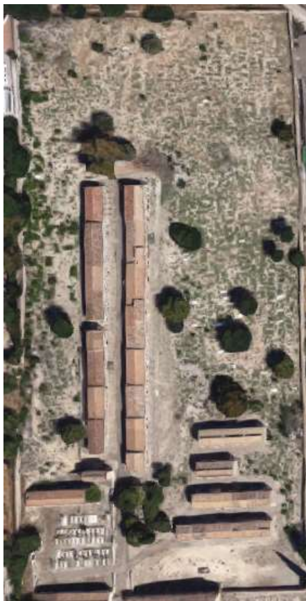
Foto 10: 4° patio, cementerio San Eufrasio. Fuente: Google Maps.
