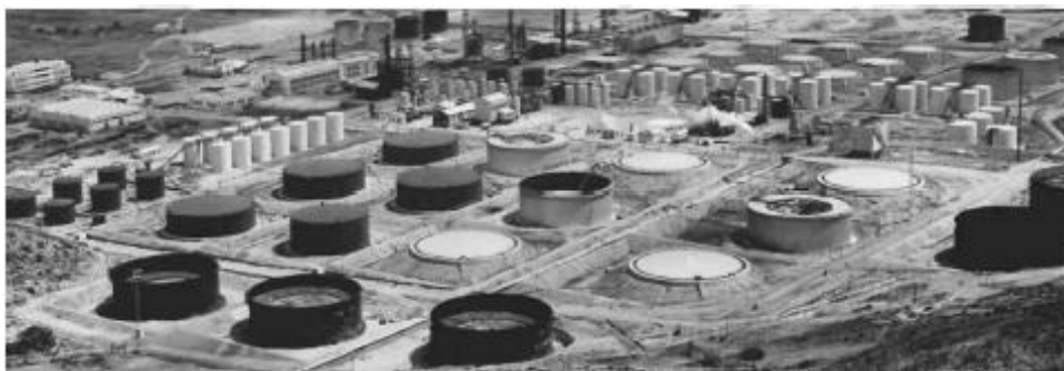
Figura 26. Foto de la Refinería de Petr leos de Escombreras S.A (REPASA) en Cartagena.
