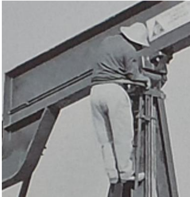
Figura 59. Operario realizando tarea de mantenimiento o ajuste de componentes.
