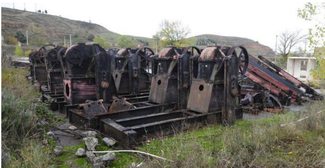
Figura 57. Piezas de bombas extractoras convencionales en proceso de desmantelamiento (bancada para motor y polea). Fuente: (El Correo de Burgos, 2019)
