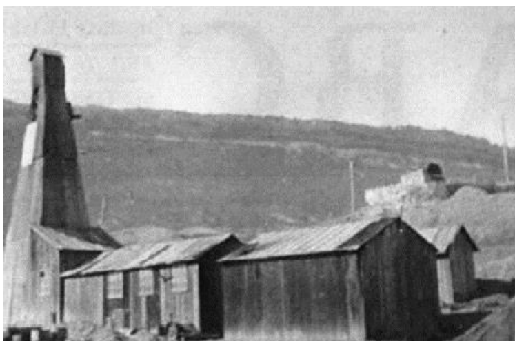
Figura 32. Torre Foraki. Sonda de CAMPSA perforando en Villanueva de Rampalay (Valle de Zamanzas, Burgos), 1946. Fuente: (Navarro & Puche Riat, 2019).
