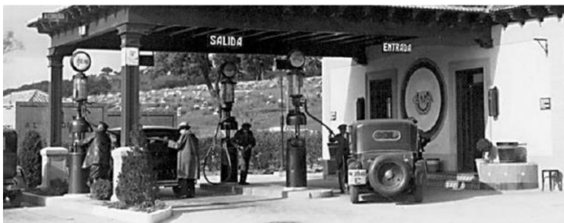
Figura 14. Estación de servicio propiedad de CAMPSA. Fuente: (REPSOL, s.f.)
