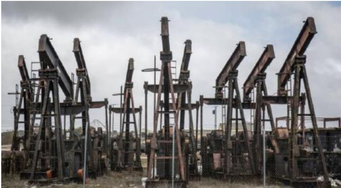
Figura 56. Doce unidades de bombeo parcialmente desmanteladas en un terreno propiedad de la empresa Columbus Energy Resources. Fuente: (Brunat, El Confidencial, 2018)
