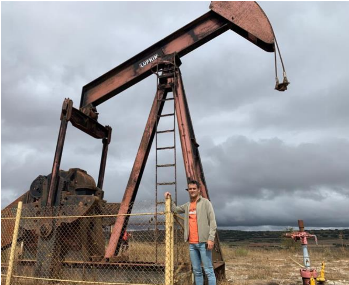
Figura 52. Muestra de una unidad convencional de bombeo en el campo de Ayoluengo, pozo nº15. Fuente: (Lora, 2022)
