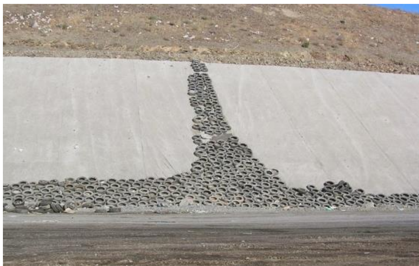
Figura 26 – Utilización de neumáticos para construcción de balsas [40].
