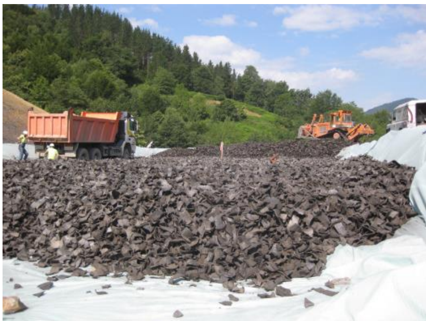
Figura 29 – Relleno de terraplenes con neumáticos usados [44].
