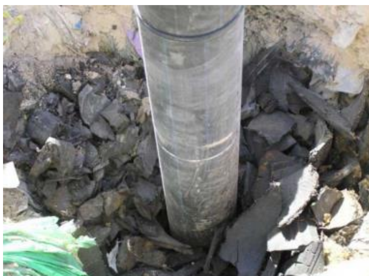
Figura 27 – Utilización de neumáticos triturados como material drenante [41].
