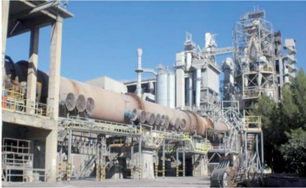
Figura 35 – Imagen del exterior de una fábrica de cemento preparada para la valorización energética [52].
