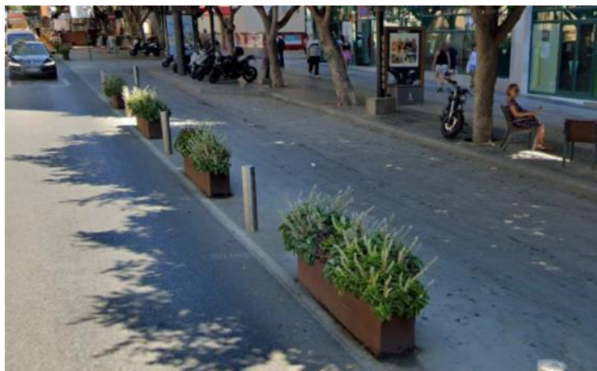
Figura 44. Ampliación de acera en el Paseo de Almería
