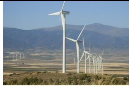
(Ilustración 15: Central eólica de Guadix. Fuente: www.juntadeandalucia.es)
