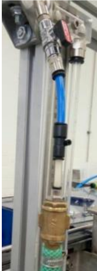
Ilustración 10. Purgador de aire del tubo de Pitot.
