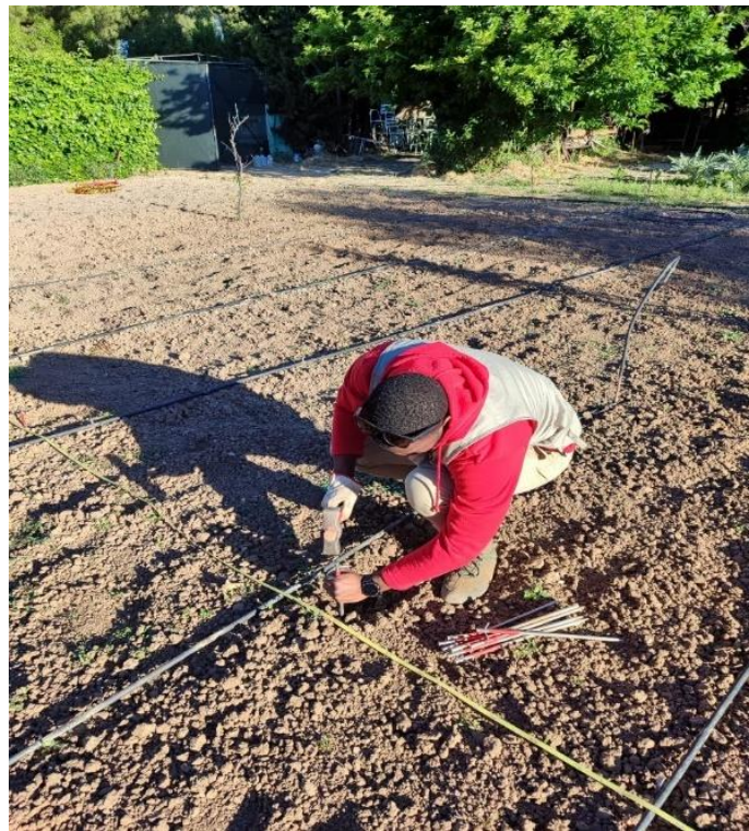
Figura 34. Colocación de los electrodos. Fuente: propia
