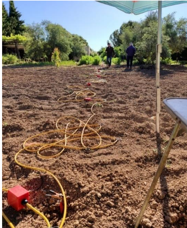
Figura 35. Conexión del cableado y los electrodos. Fuente: propia
