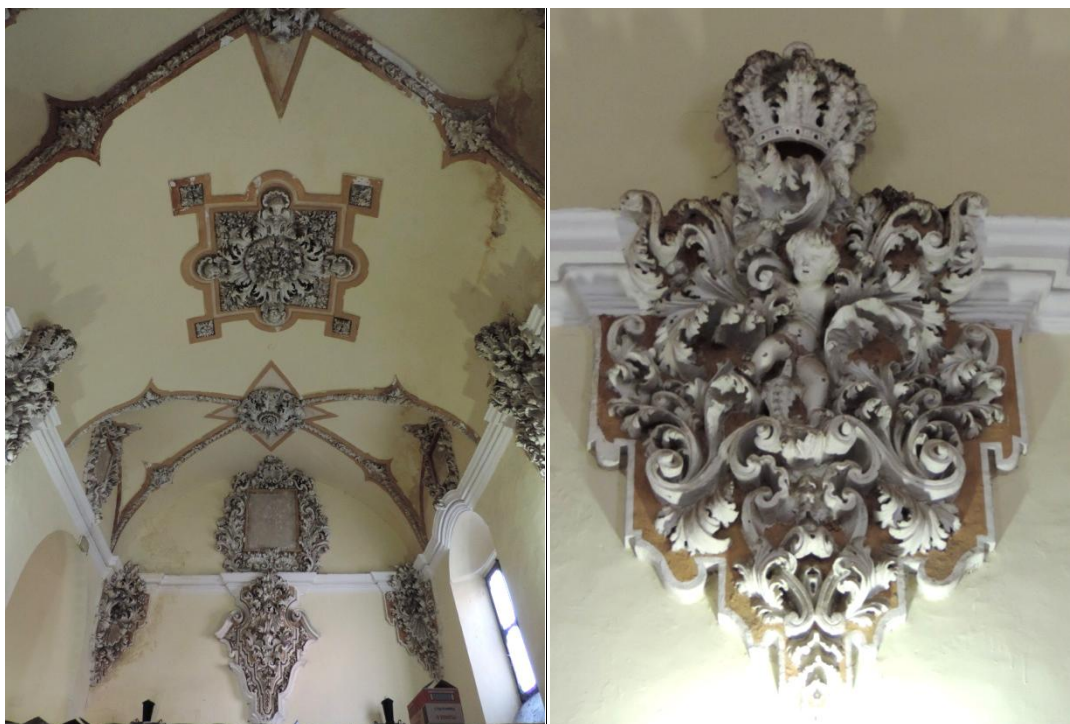
Fig. 76: Bóveda capilla / Foto propia
