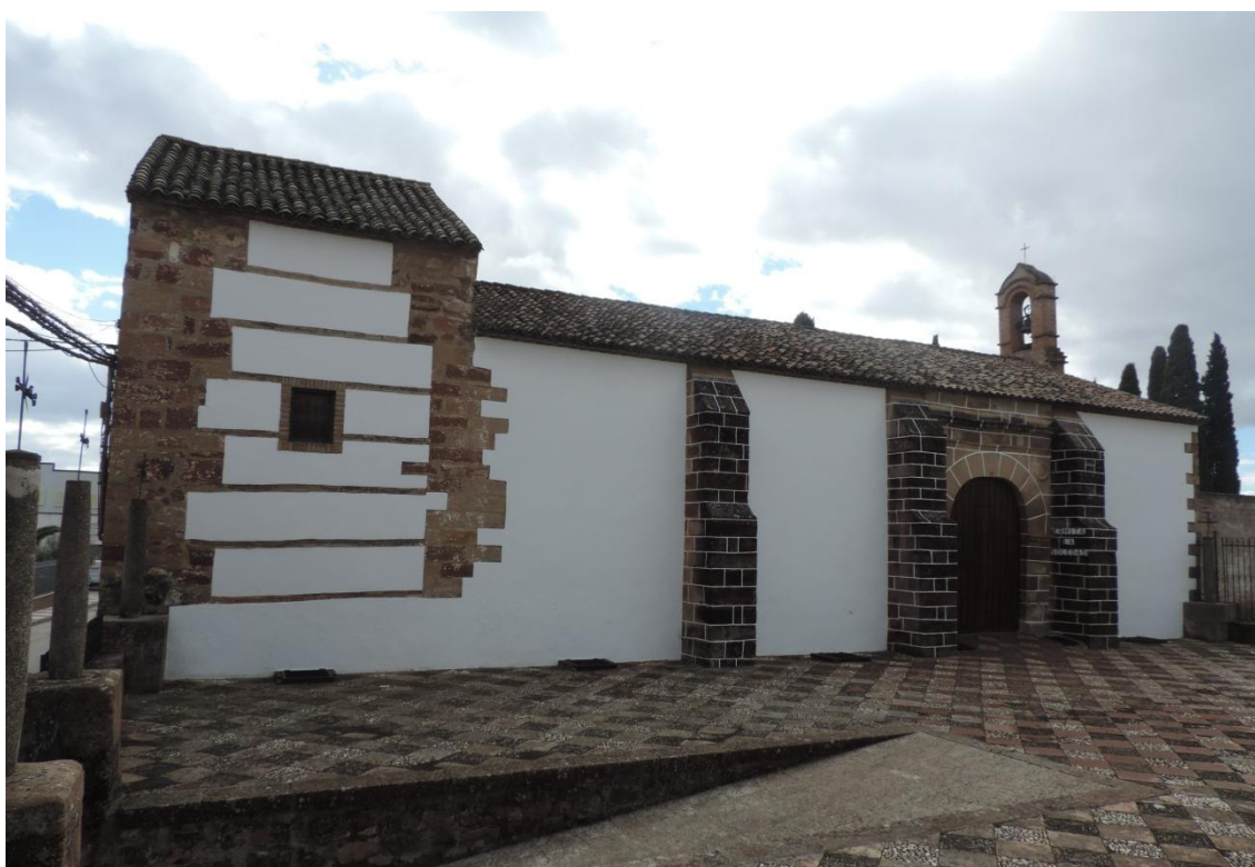
Fig.17: Exterior ermita de la Soledad / Foto propia
