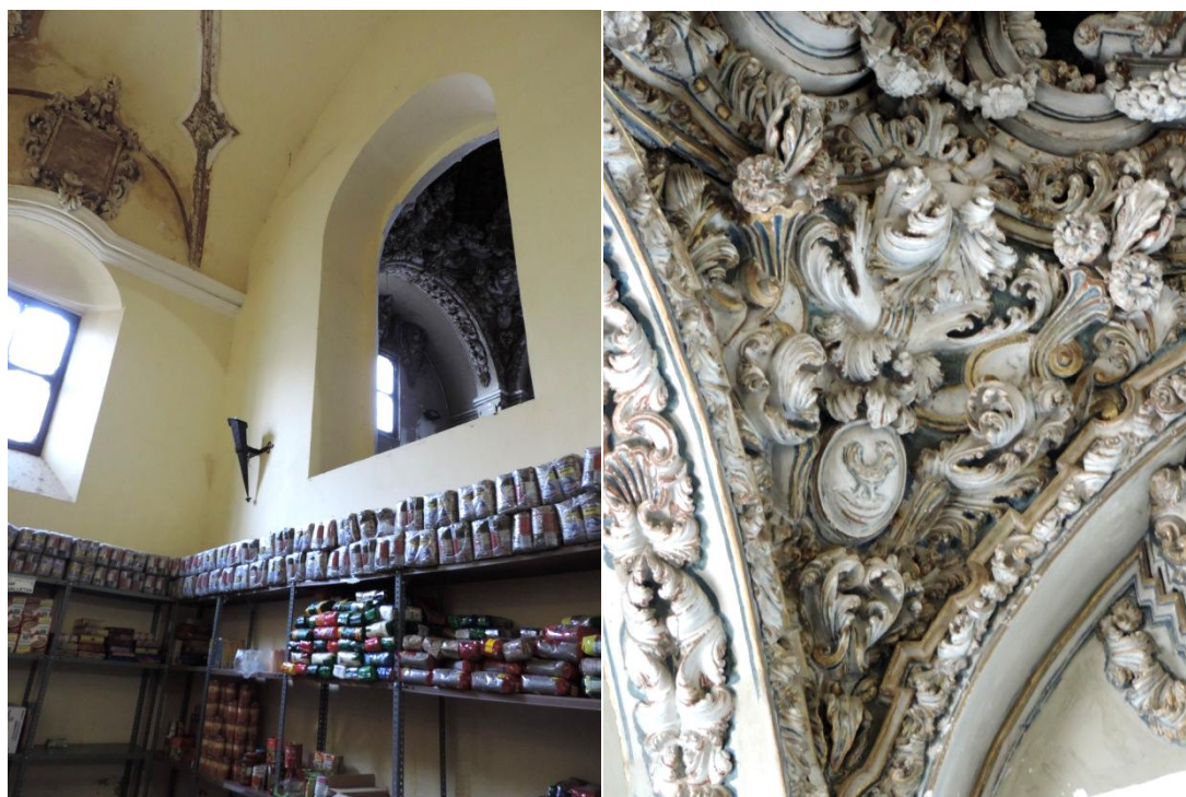
Fig. 78: Arcos de conexión con el camarín / Foto propia
