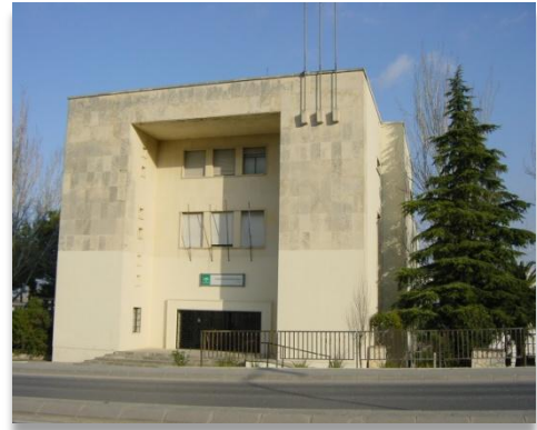
Figura 2: Fachada principal del centro educativo
