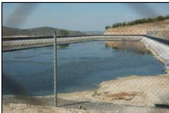
Foto: Balsa de decantación. Autor: Jose Villar
