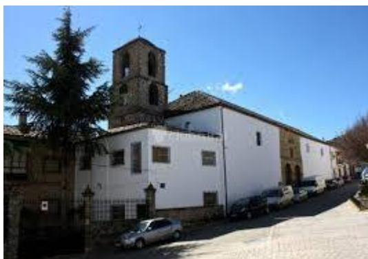
Ilustración 1.2.2. Convento de Santa Ana.
