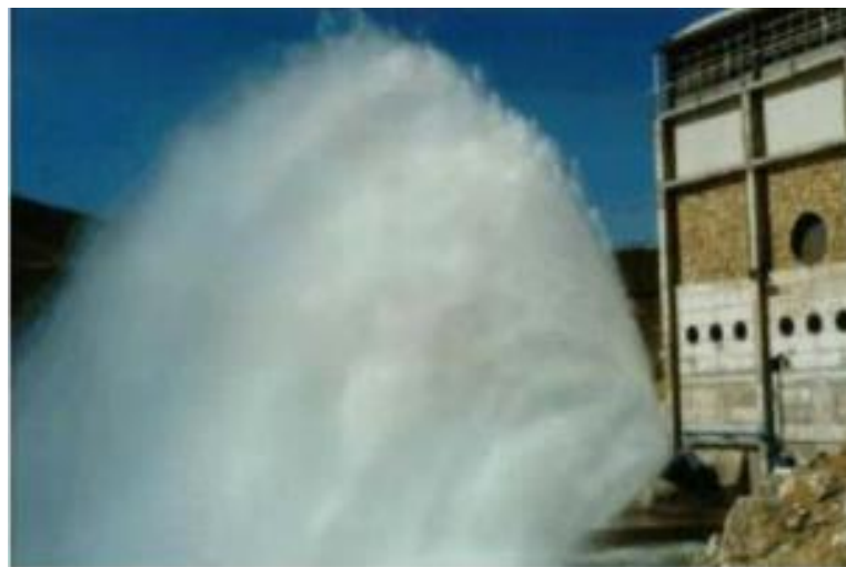
Ilustración 38: Canal de desagüe
