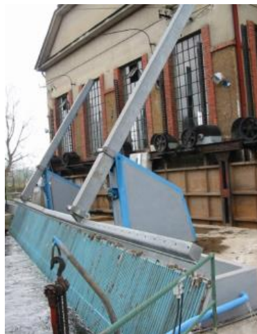
Ilustración 36: Limpiarrejas telescópico
