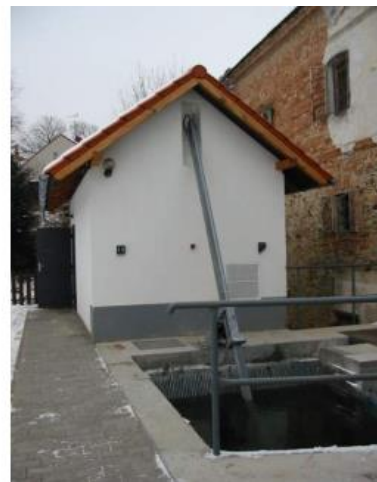
Ilustración 36: Limpiarrejas telescópico
