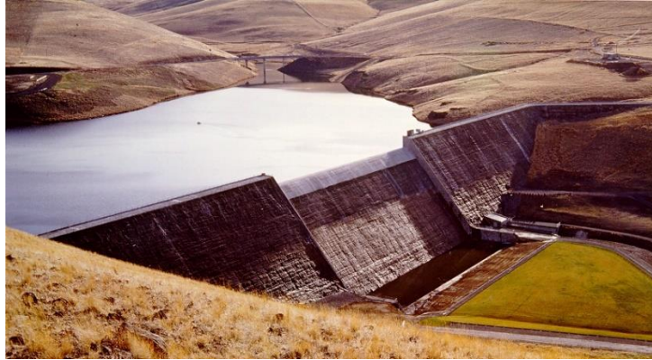
Ilustración 5: Presa de gravedad
