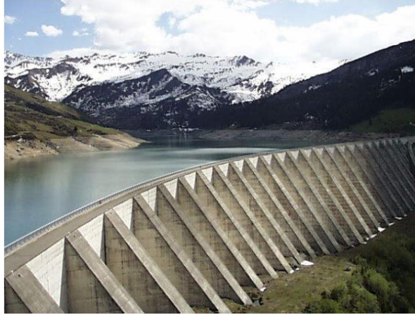
Ilustración 9: Presa de contrafuertes
