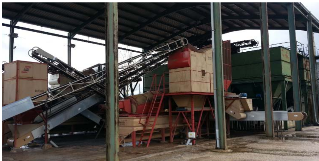
FIGURA 13: PANORÁMICA GENERAL DE LA ZONA DE LIMPIEZA.
