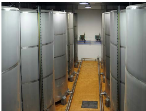
FIGURA 20: BODEGA DE ALMACENAMIENTO.
