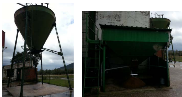
FIGURA 24: DETALLE DEL ALMACENAMIENTO DEL ORUJO Y EL HUESO.
