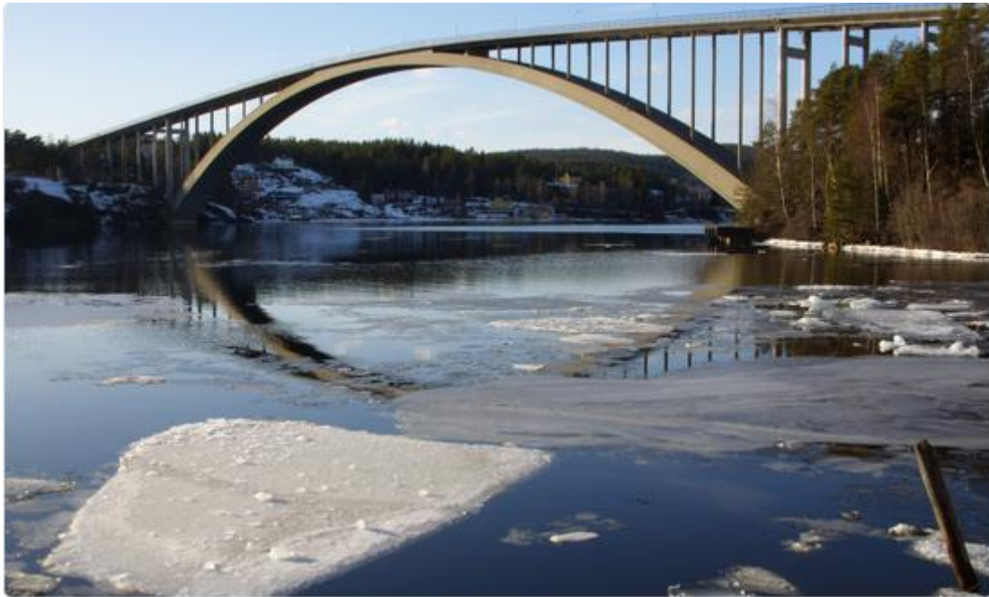
Figura 2.32- Puente de Sando, 264 metros de luz
