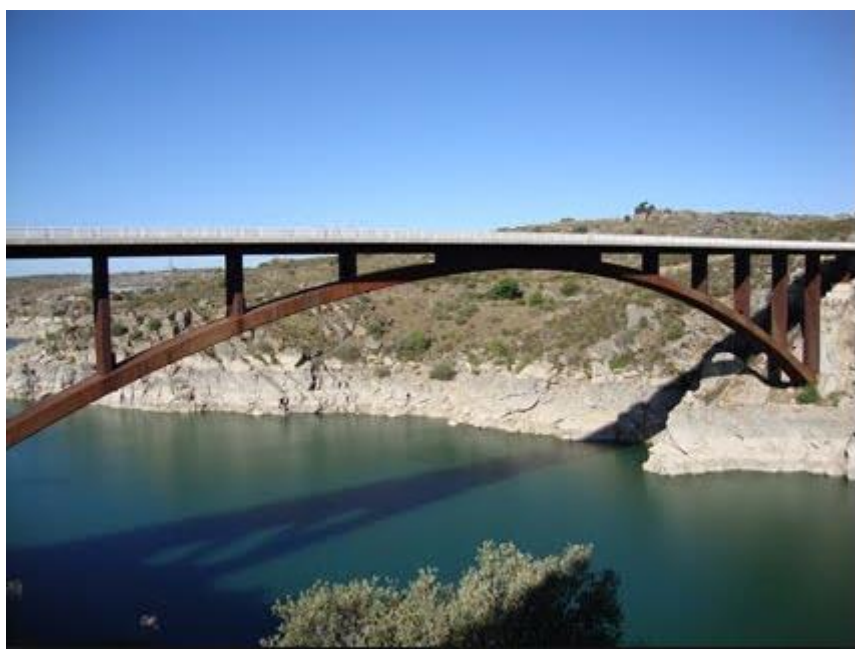
Figura 2.34- Puente sobre el embalse de Ricobayo
