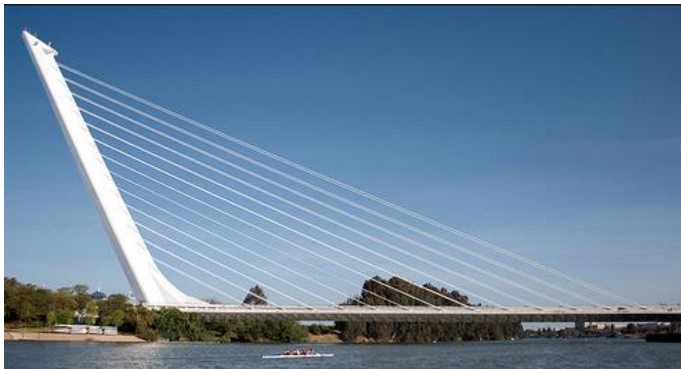
Figura 2.27 – Puente del Alamillo, Sevilla
