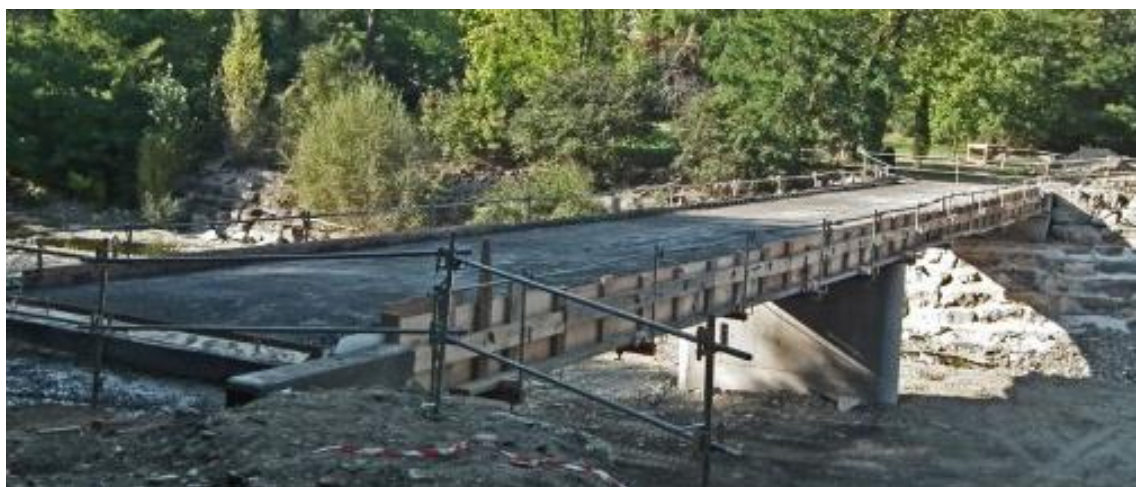
Figura 2.18: Tablero de hormigón armado en ejecución (aún tiene el encofrado)
