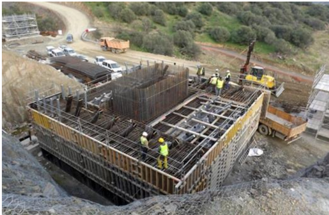
Figura 2.8 – Ejemplo real de la construcción de una zapata
