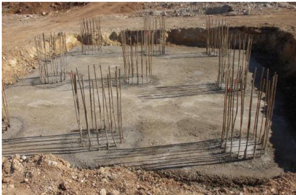
Figura 2.10 – Ejemplo real de la cimentación por pilotes
