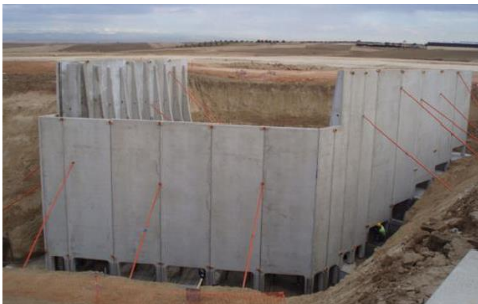
Figura 2.14 – Estribo cerrado de hormigón con aletas
