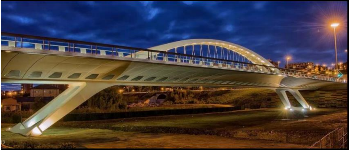
Figura 2.35- Puente de Juan José Arenas en Santander
