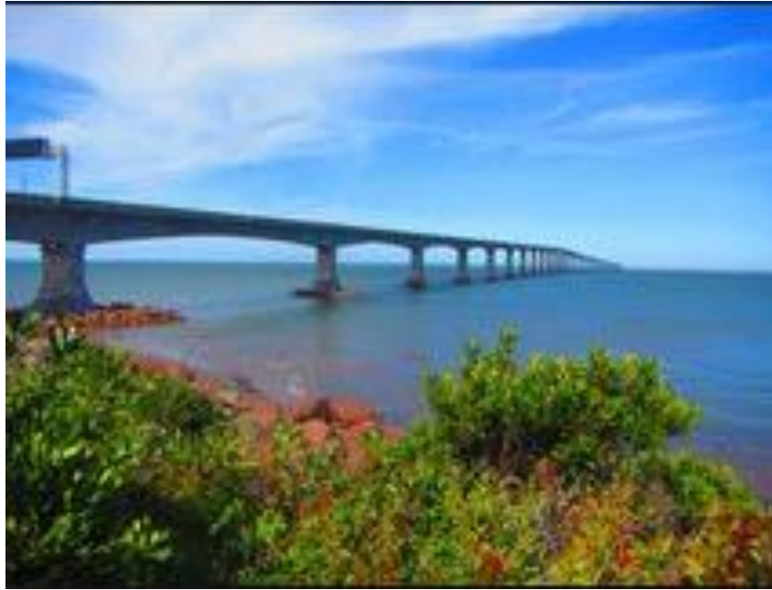
Figura 2.23 – Puente de Northumberland, Canadá
