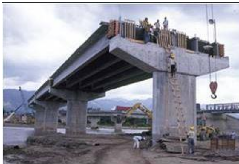
Figura 2.20 – Tablero nervado con vigas
