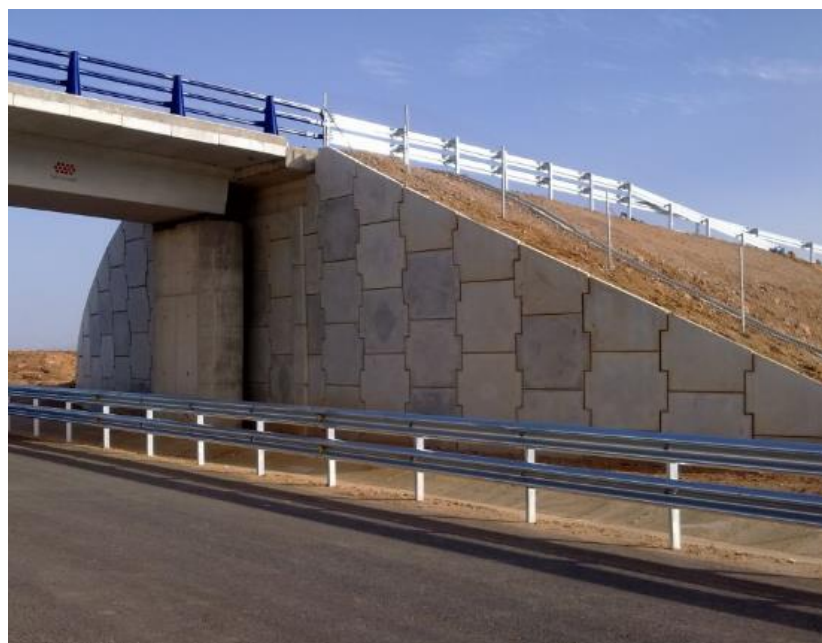
Figura 2.16 – Estribo de tierra armada
