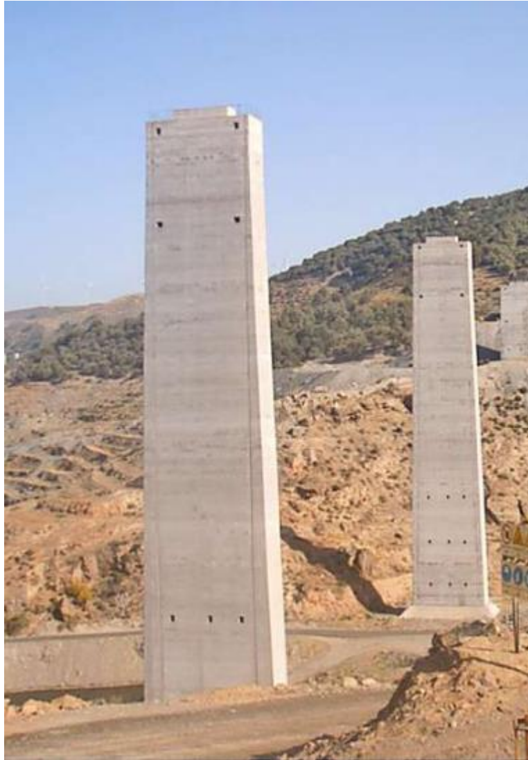
Figura 2.11 - Pilas intermedias de un puente en ejecución
