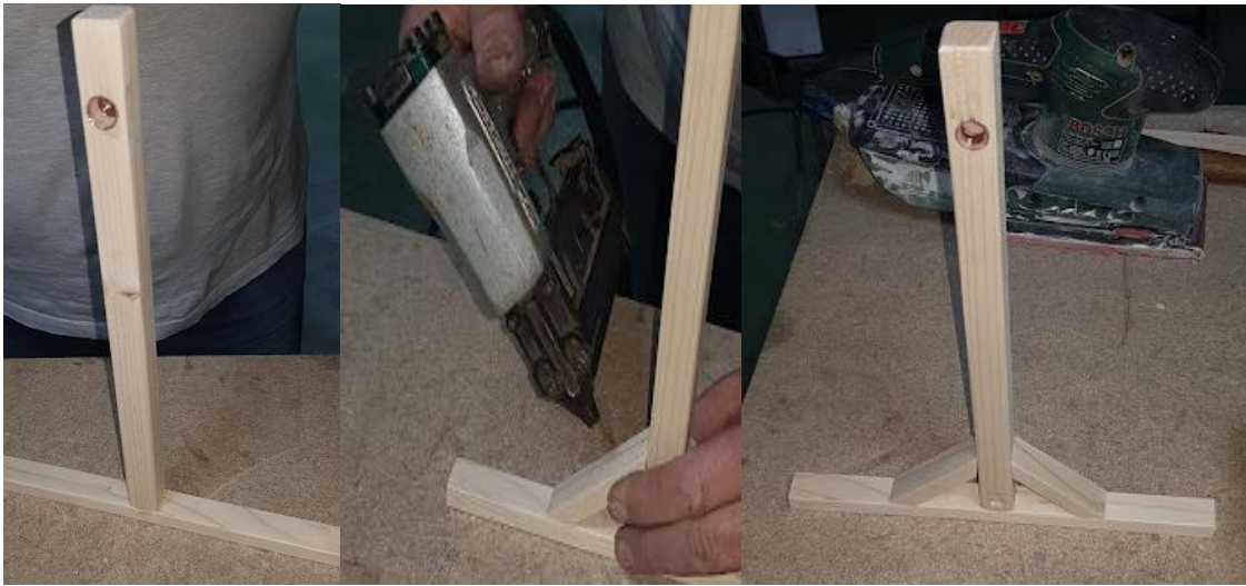
Ilustración 8.47: Montaje de listón 1A del torno. Fuente: Elaboración propia
