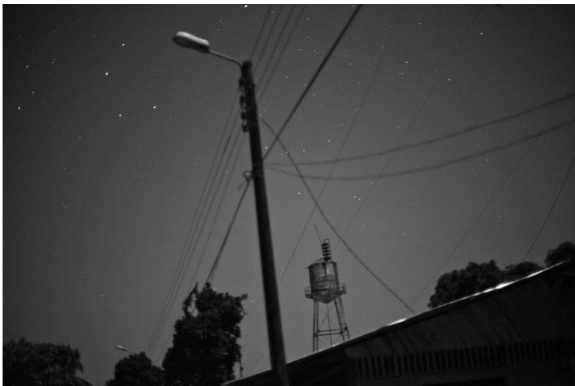
Ilustración 2: Tendido eléctrico en el centro urbano
